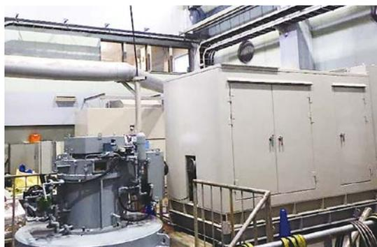
写真2 マスプロダクツ型排水ポンプ(200kW級)設置状況
