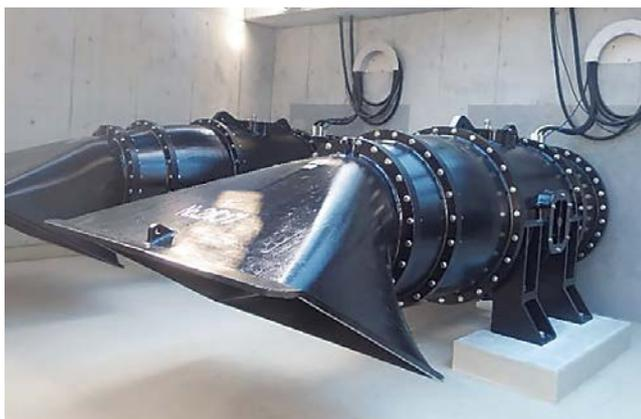
【高速斜流水中ポンプ・低水位対応型】
