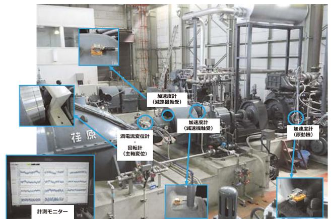
写真3 排水機場のセンサー設置状況
