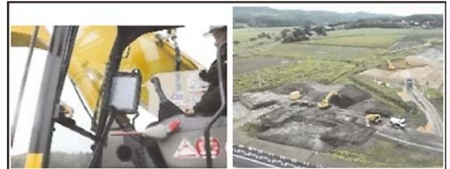
図5 ICT建機による施工
