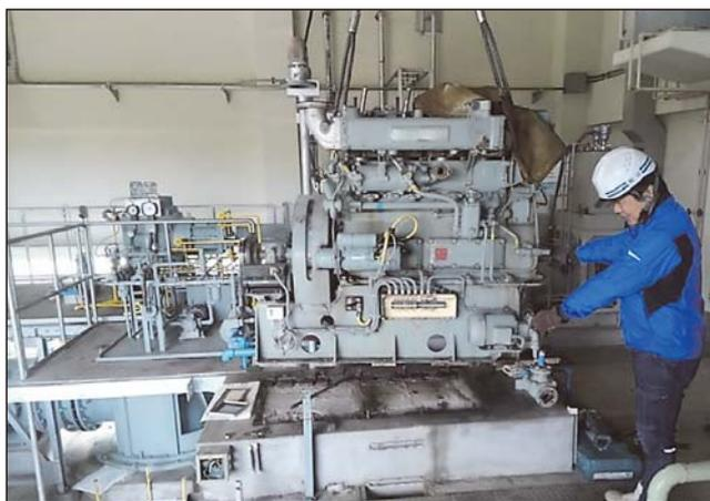
図-10 旧原動機更新のため撤去
