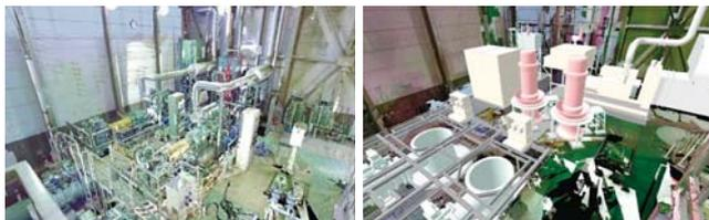
図-6 更新工事前の機場内点群データ 図-7 点群データと 3D モデルの組み合わせ
