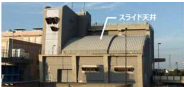
写-9 鳥屋野潟排水機場外観
