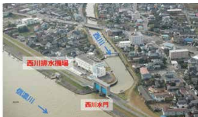
写－1 西川排水機場全景
