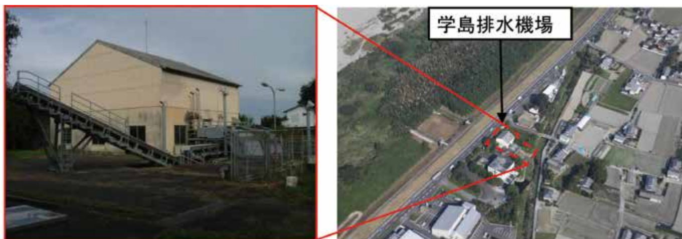
図－2 学島排水機場外観
