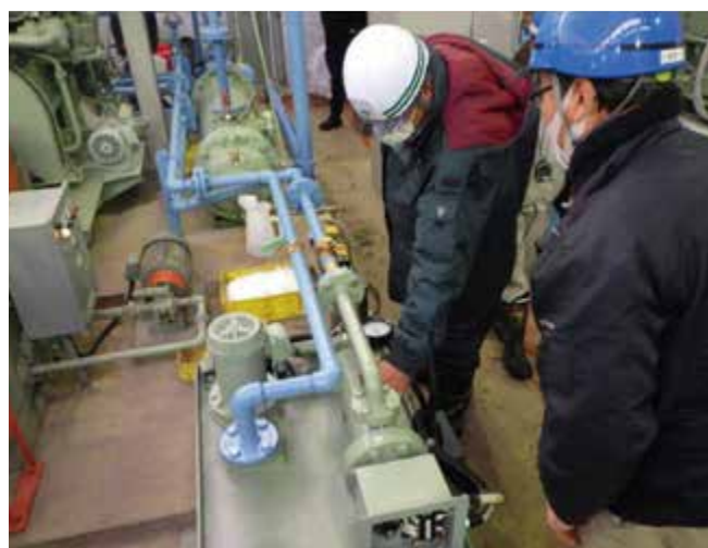
写－11 冷却水加温装置追加（豊栄排水機場）
