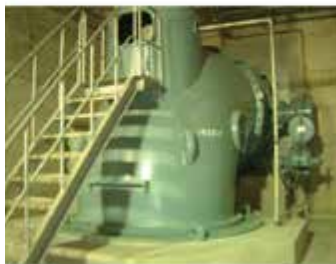
写-8 左：立軸ガスタービンエンジン 右：主ポンプ
