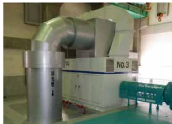
写－5 ガスタービン整備後及び給排気系統更新後
