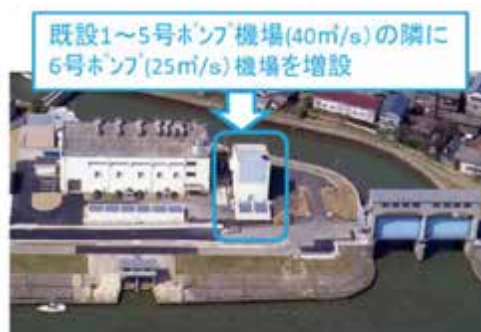
写真3 増設後の西川排水機場
