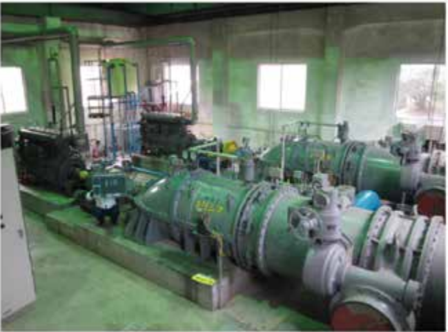
写－1 学島排水機場設備全景(工事前)
