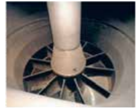
写－５ 主ポンプ（立軸軸流二床式）
