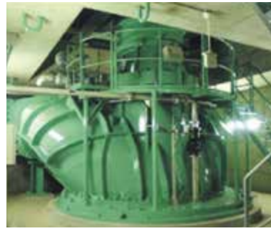
写－５ 主ポンプ（立軸軸流二床式）
