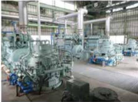
旧施設（立軸斜流ポンプ+原動機）
