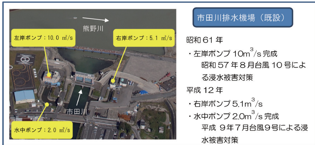
図-2 市田川排水機場 既設全景
