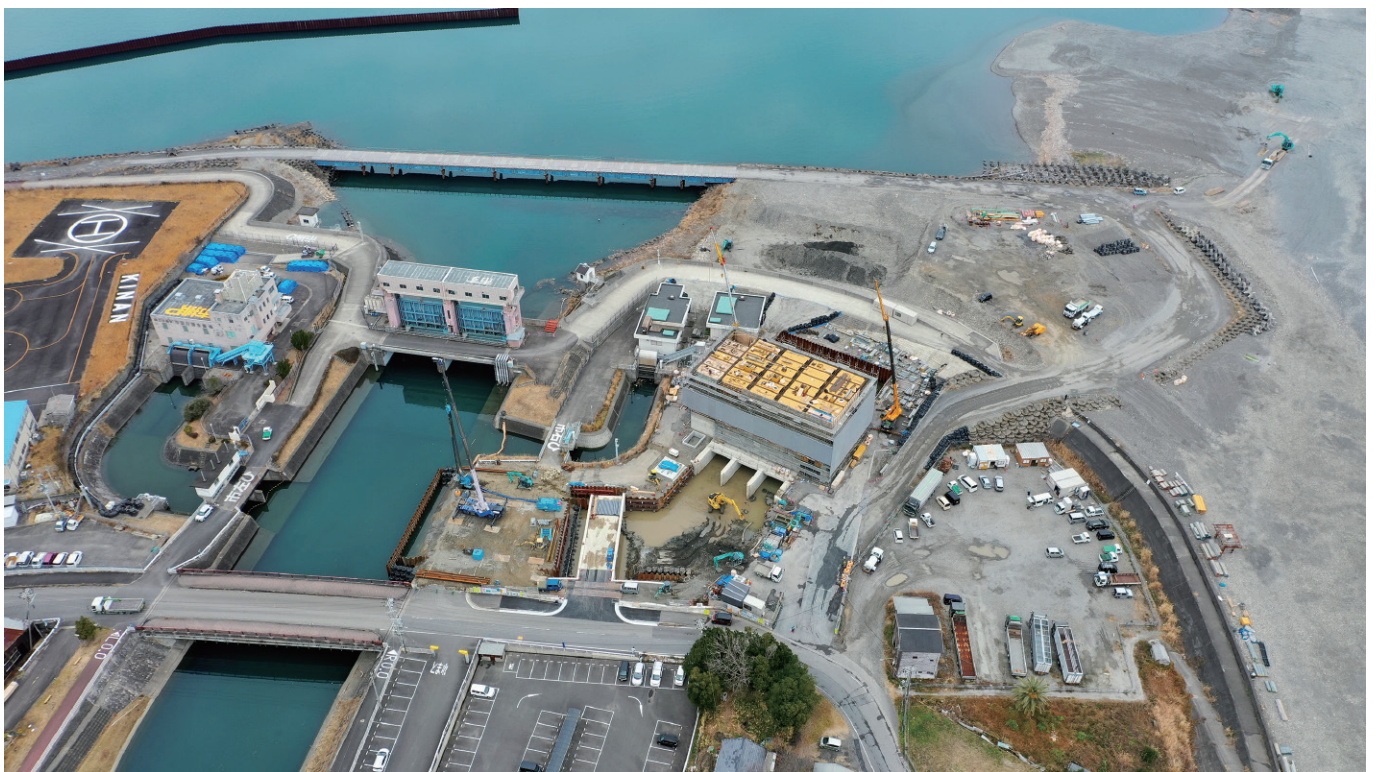
写一 建設の進む市田川排水機場（2022年1月撮影）
