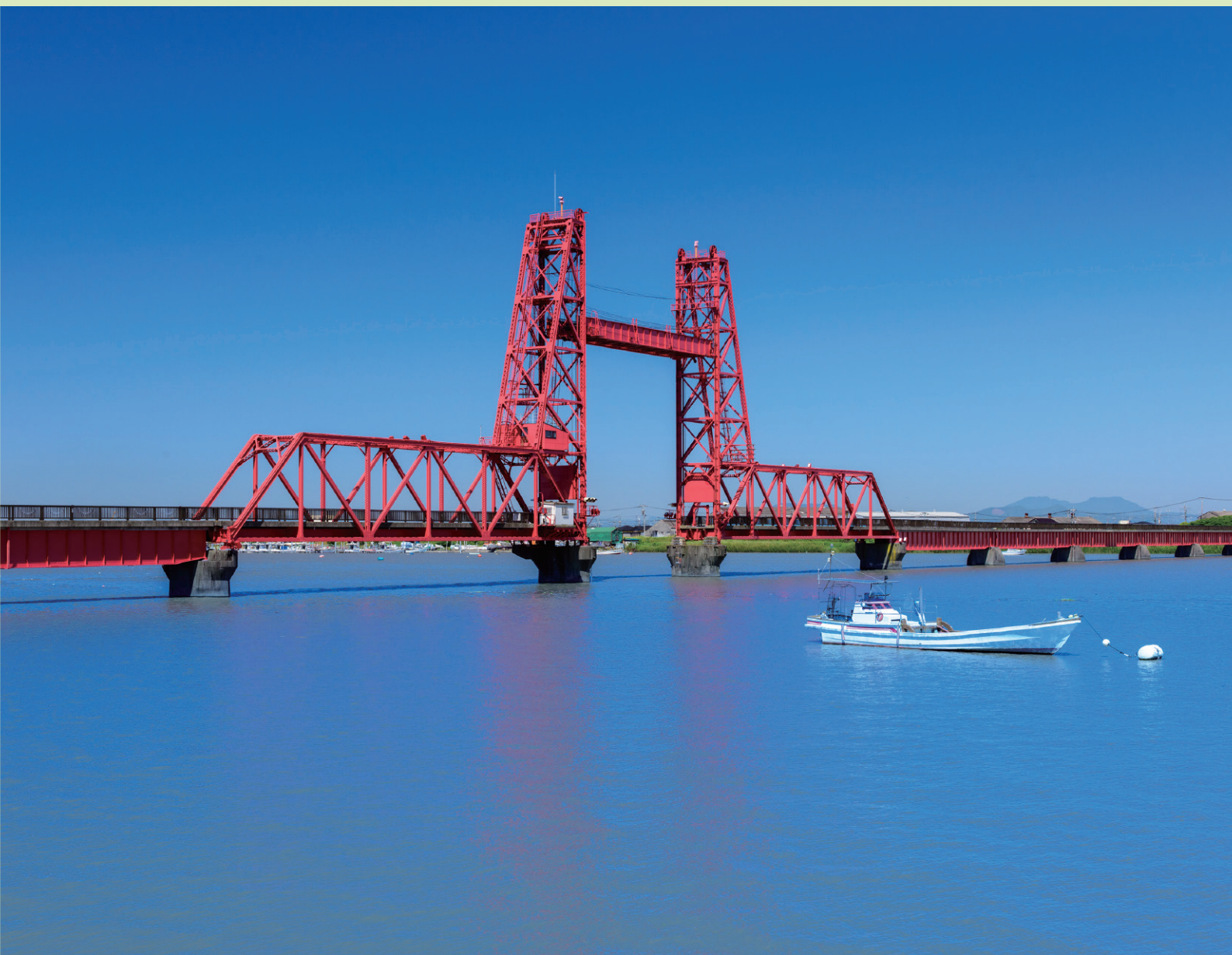
筑後川昇開橋（福岡県）
