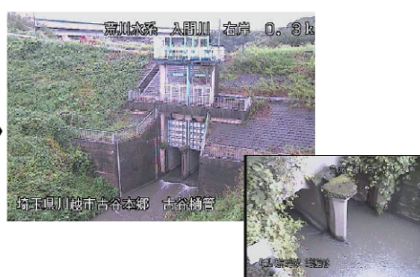
CCTVによる安全確認
