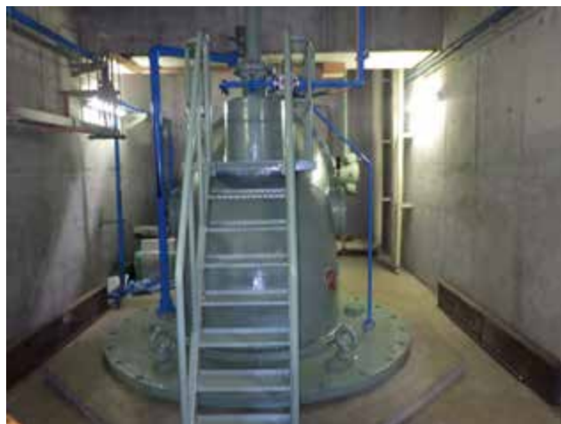
写－４ 整備工事完成状況（主ポンプ）
