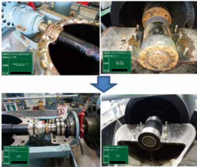
図－9 無給水軸封装置改造前後
