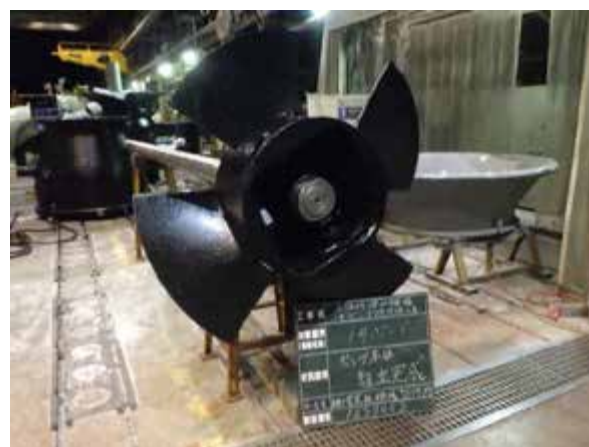
写ー１ インペラブレードの補修状況
