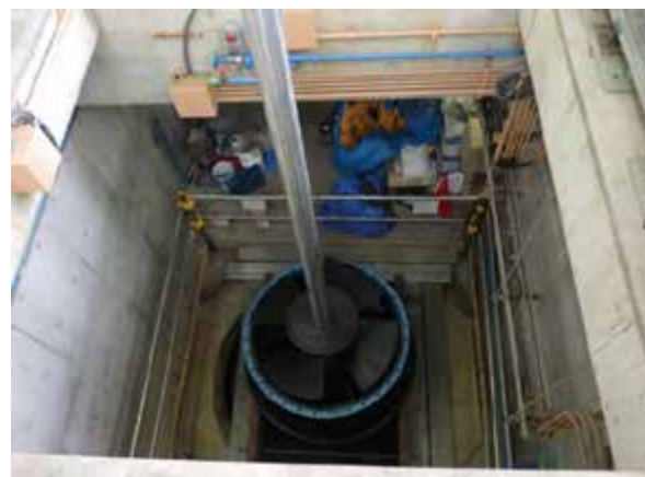
写ー２ インペラの設置状況
