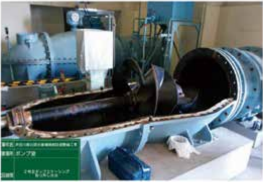
写-2 主ポンプケーシング内部
