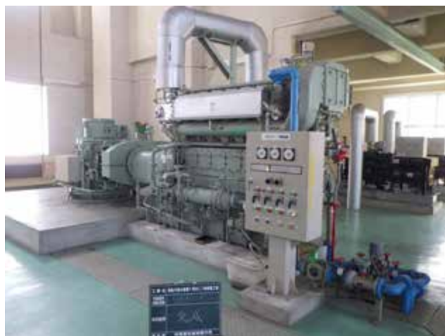
写－５ 整備工事完成状況（主原動機・減速機）
