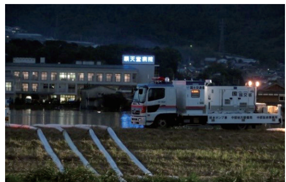
写－1 排水作業の状況（佐賀県大町町）
