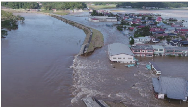
令和元年東日本台風時の氾濫被害の状況（吉田川）
