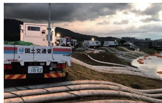
写－2 排水作業の状況（佐賀県大町町）
