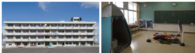
写－２ 仙台市立荒浜小学校
