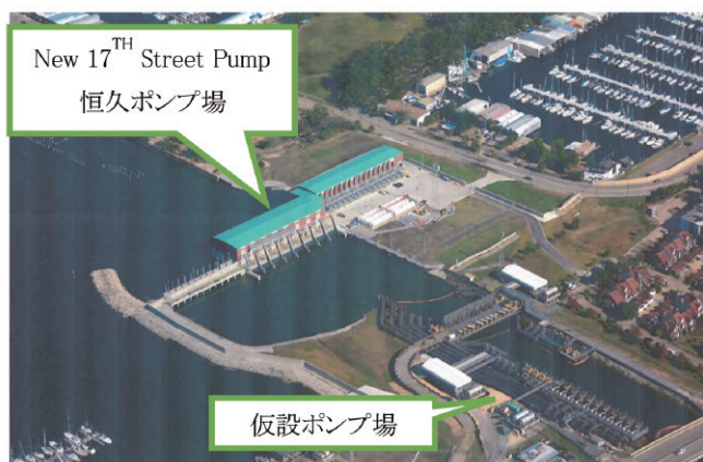
図ー7 ポンプ場上空写真（出典：工兵隊）
