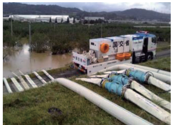
写－4 排水作業の状況（長野県小布施町）
