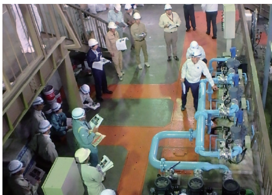
写 3 - 1 ポンプ設備の冬期管理要領の説明
