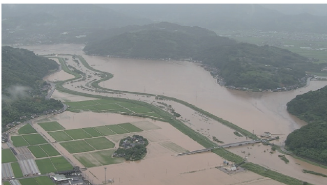
令和元年8月の前線に伴う大雨時の氾濫被害の状況（牛津川）
