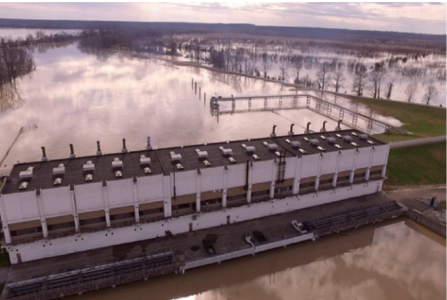
図- 18 W. G. Huxtable Pumping Plant 全体写真 (出典：工兵隊)
