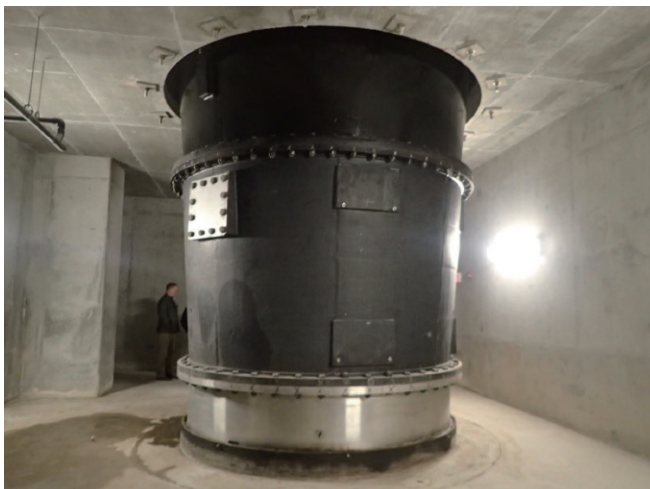
図ー 13 立軸軸流ポンプ
