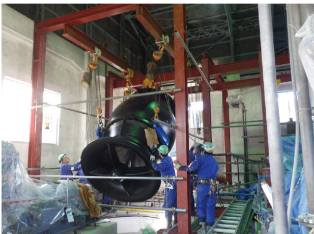
写－6 ポンプ搬入および据付状況
