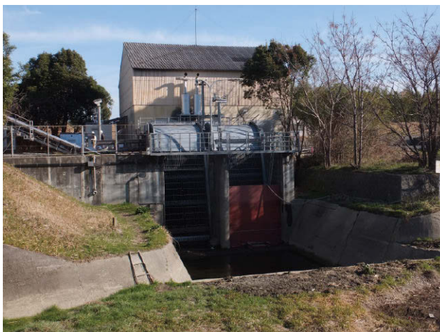
写－１ 機場外観（機場外）
