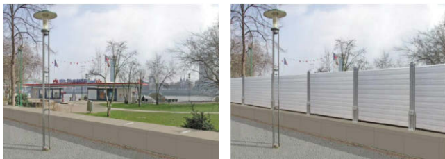
写真2 モバイルウォール（左：撤去時、右：設置時） （出典：StEB Köln 提供資料）
