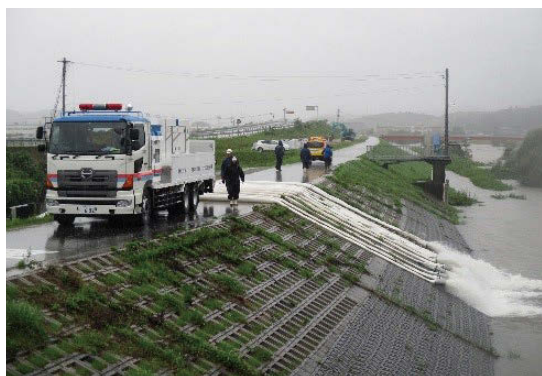
写－5 排水作業の状況（鳥取県倉吉市）
