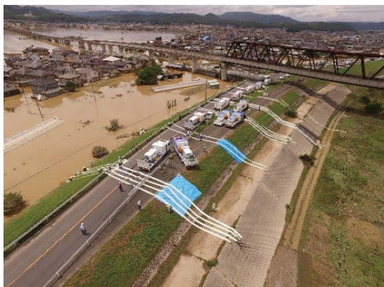
写－1 排水作業の状況（岡山県倉敷市）
