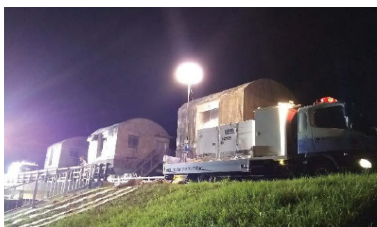
写－6 排水作業の状況（宮崎県宮崎市）
