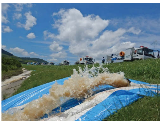
写－2 排水作業の状況（岡山県倉敷市）
