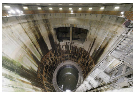
写－5 迫力の深さ70mの「巨大竖穴」第1立坑
