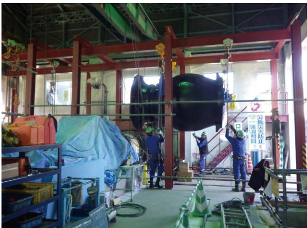
写－5 ポンプ搬入および据付状況
