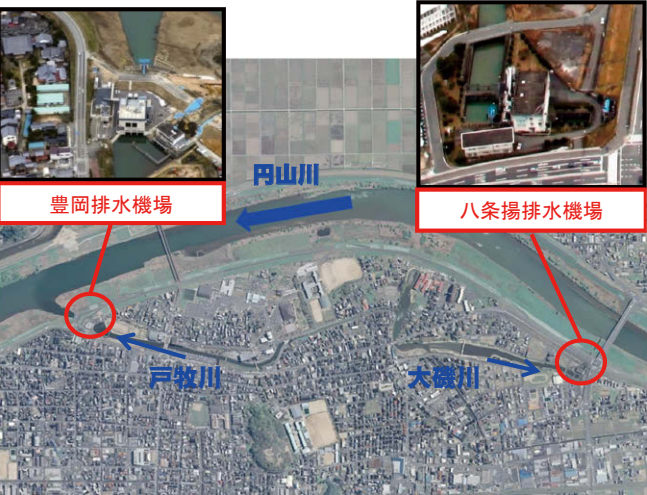
写－1 豊岡排水機場・八条揚排水機場の上空写真
