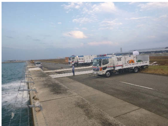
写－3 排水作業の状況（大阪府泉佐野市）
