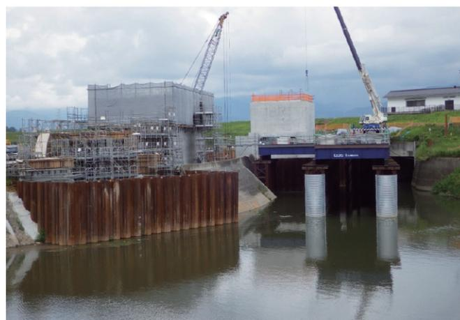
写-8 仮設構台を使用しての制水ゲート据付状況
