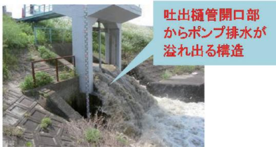
図-4 排水運転時の吐出樋管出口
