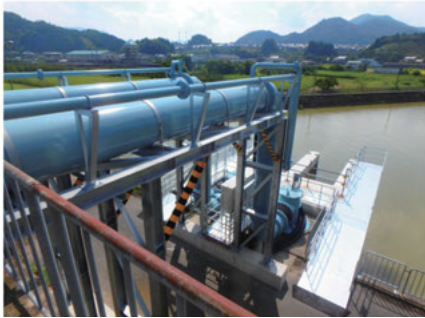
写－10 緊急排水ポンプ設備 3.0m 3 /s
