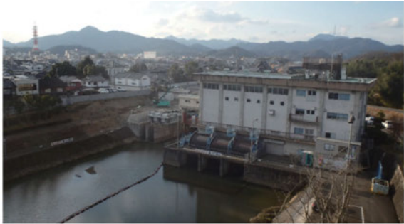
写－12 法川排水機場全景
