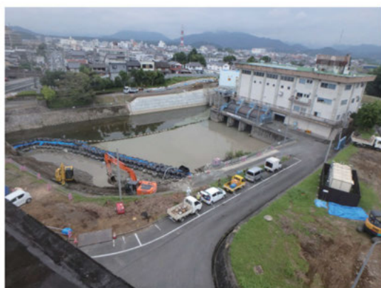
写真 14 法川排水機場施工状況（H29.9.6 時点）
