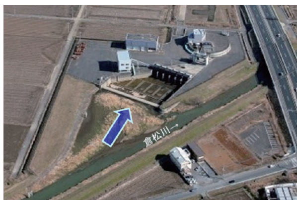
写－6 倉松川流入施設 (越流堤)
