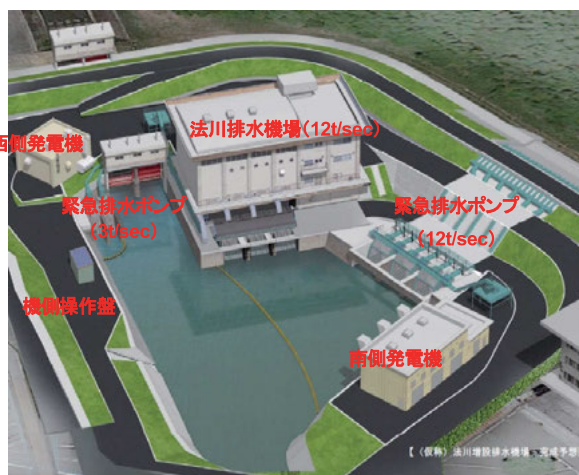
図－9 法川排水機場 増設ポンプ設備完成予想図
