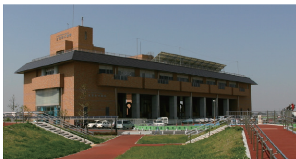
写－2 庄和排水機場
