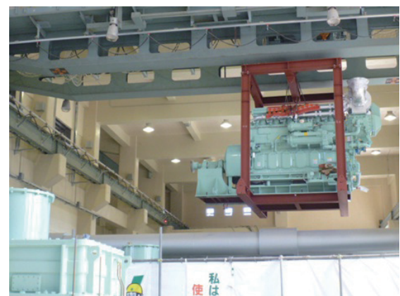
写－５ 主機搬入および据付状況
