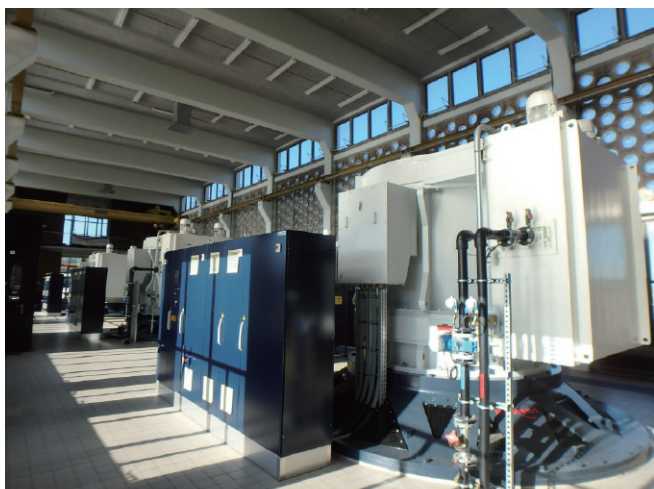
写－６ 主ポンプ駆動設備設置状況
