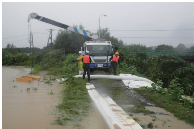
写－６ 下川町での排水作業
