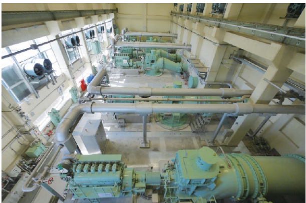
写ー２ 機場外観（機場内）
