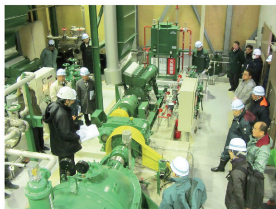
写4-2 排水機場点検時の留意点の説明
