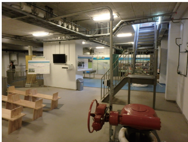
写－12 ポンプ室内の学習スペース
