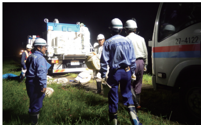
写－７ 職員と作業員の排水作業打合せ状況
