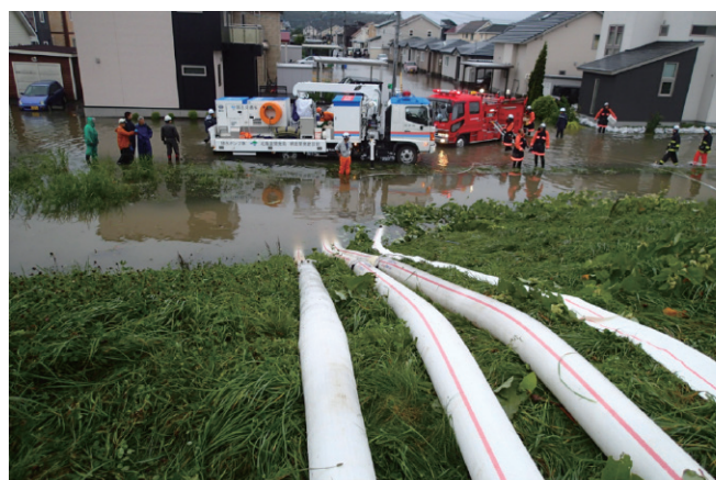
写－８ 音更町での排水作業
