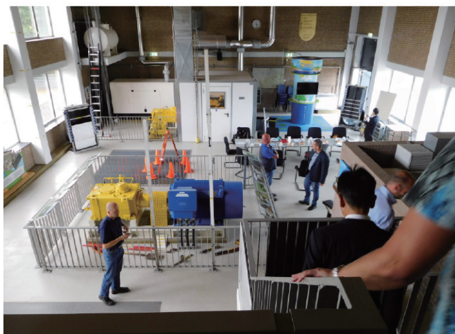
写－３ 主ポンプ駆動設備設置状況
