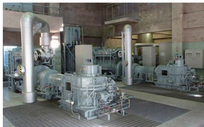
写－1 TJ10 排水機場
