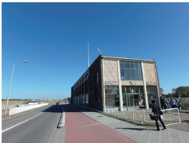
写－13 ポンプ場建屋外観
