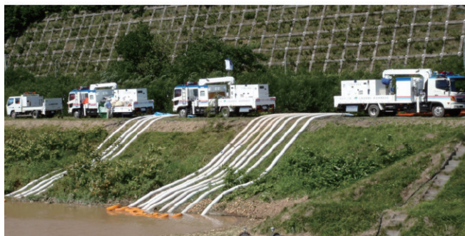
写ー 4 北見市常呂（常呂川）の排水作業
