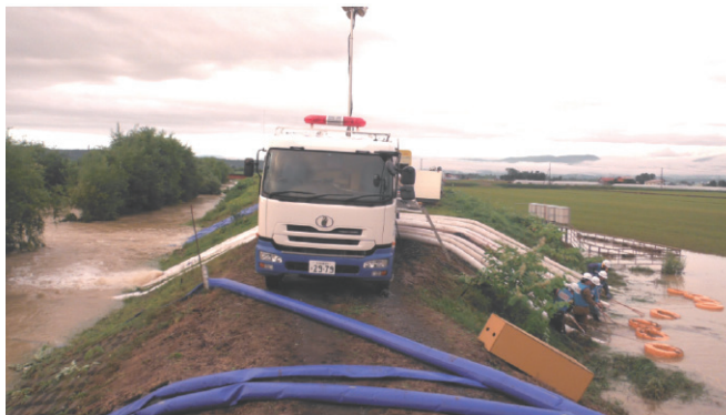
写－５ 名寄市での排水作業
