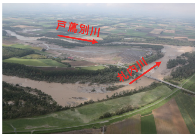
写-3 札内川の被災状況
