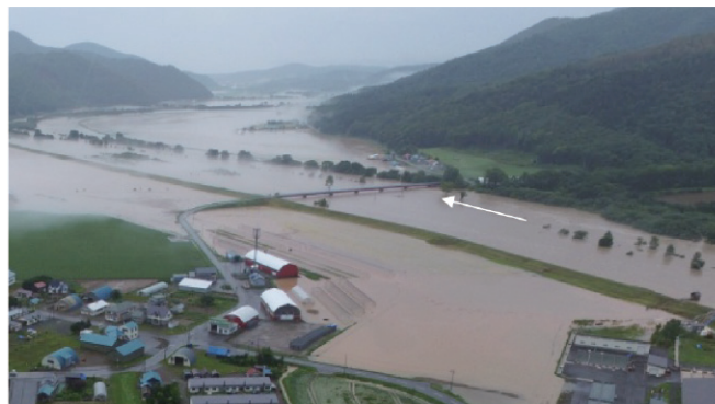
写－1 常呂川の被災状況
