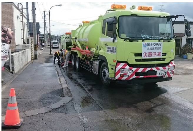
写－12 芽室町での排水桝清掃状況
