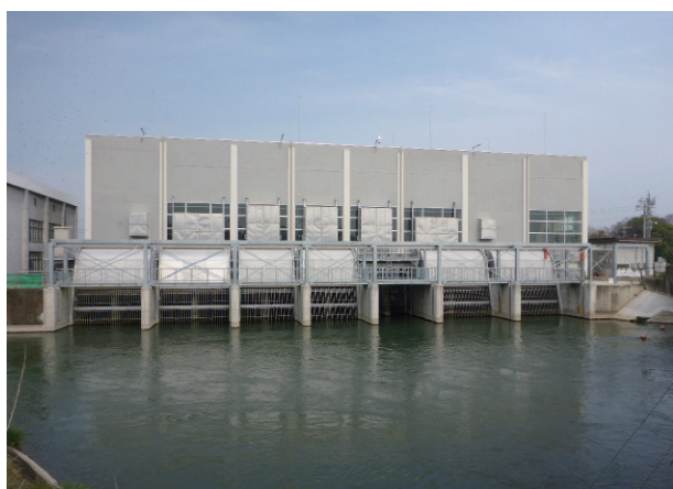
写ー１ 機場外観（機場外）
