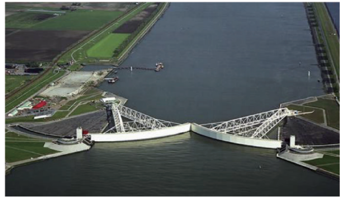
写－10 マエスラント可動堰（全閉時）
