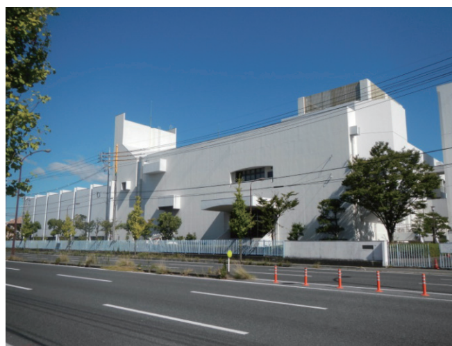
写－6 平井排水機場（岡山市平井排水センター）
