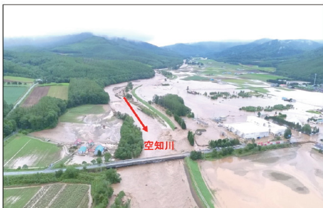
写-2 空知川の被災状況
