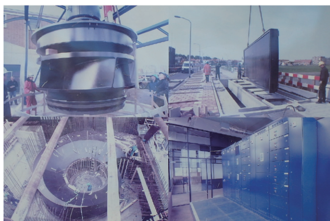
写－５ 改造工事状況
