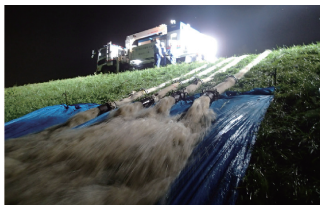
写－ 9 幕別町での排水作業
