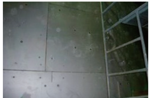
写－４ 土木耐震補強
