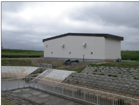
写－３ 雁来揚水機場外観
