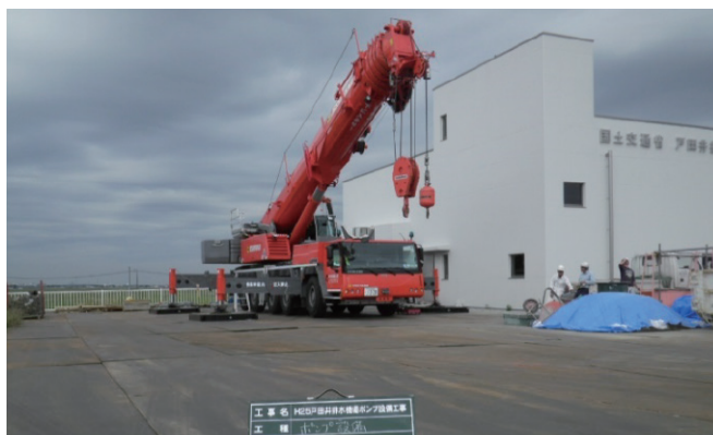
写－6 220Tonトラッククレーン
