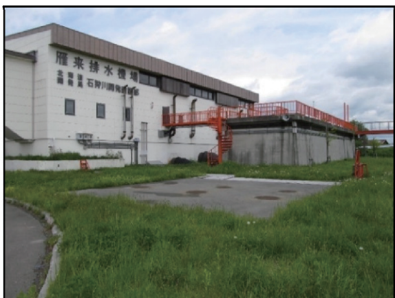
写－１ 雁来（旧）排水機場外観
