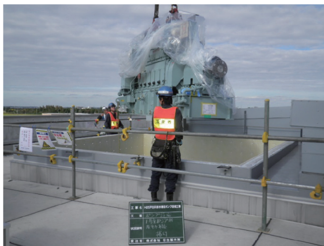
写－5 主原動機搬入状況
