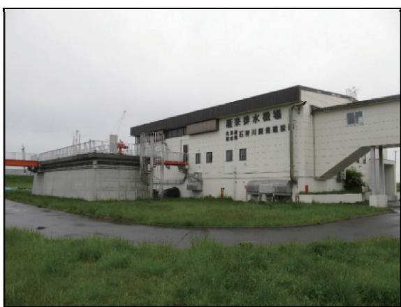
写－２ 雁来（新）排水機場外観
