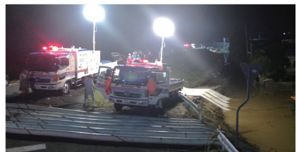
排水ポンプ車による排水作業状況（平成27年 関東・東北豪雨）
