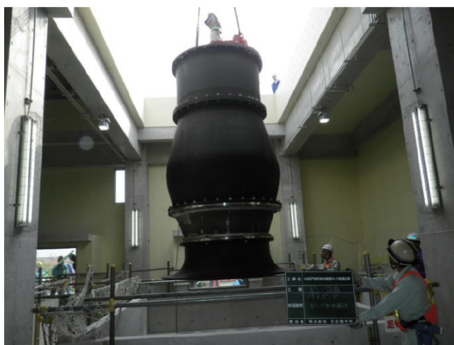
写－4 主ポンプ搬入状況
