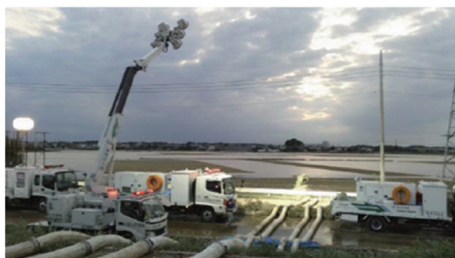
写－11 八間堀川での排水状況
