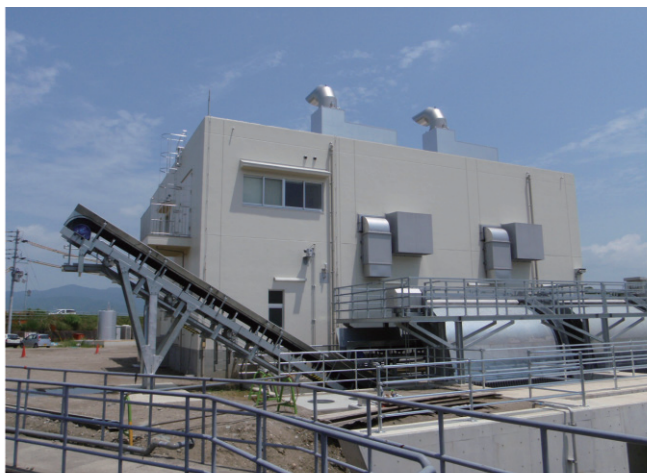
写－３ 新川島排水機場全景
