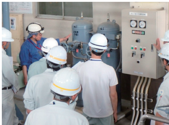
写 2-2 空気槽の常用－予備切替操作
