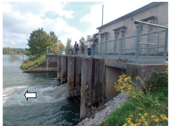
写－３ ブラング左岸排水機場 外観
