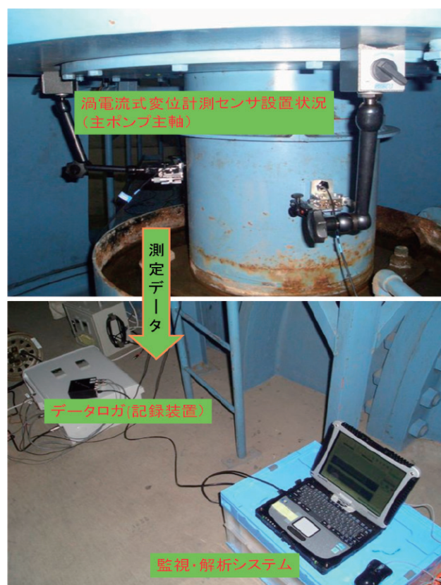
写－2 主ポンプ主軸露出部の振動計測状況
