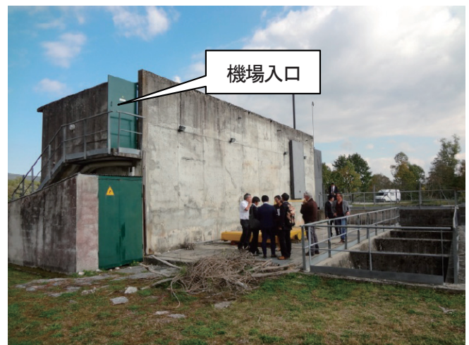
写－４ ブラング左岸排水機場入口
