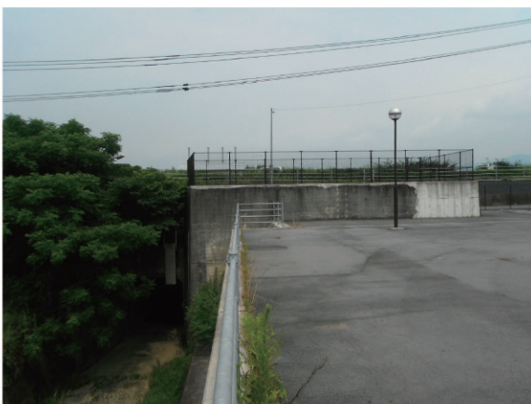
写－7 既設吐出水槽
