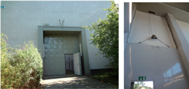
写－5 耐水構造の搬出入扉＆降下構造の搬出入扉
