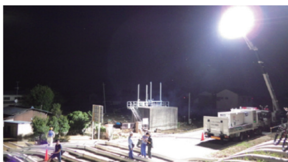
写－8 大生排水機場付近での排水状況
