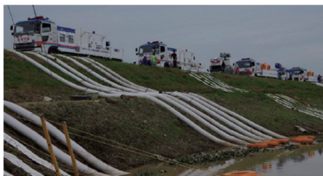
写－10 新井木での排水作業
