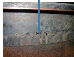
写-6 ライナの冷却水部腐食
