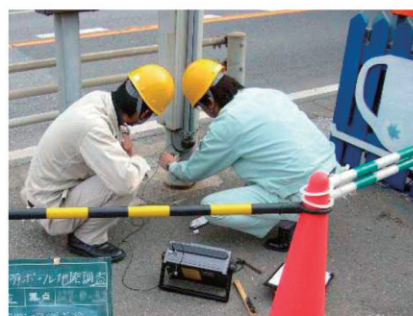
写－5 損傷調査の状況
