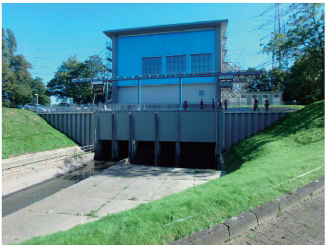
写－6 ボットロプA排水機場 流入部
