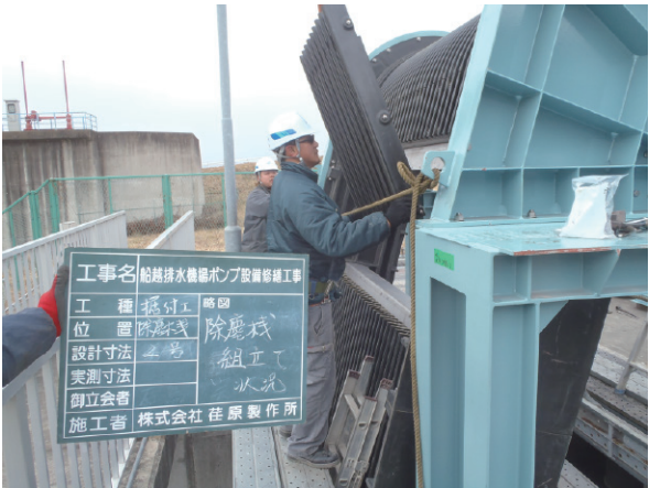
写－3 上部スクリーン設置状況
