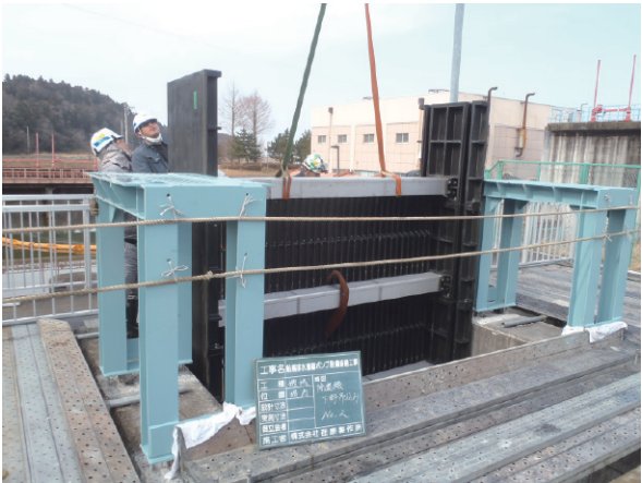
写－1 下部フレーム・スクリーン設置状況
