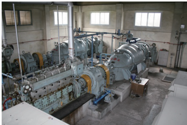
写－２ 川島排水機場
