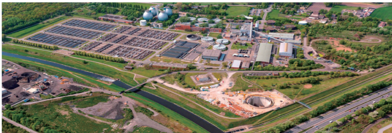
写－ 9 ボットロプ下水処理場 全景
