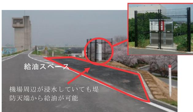
写-2 燃料給油口の高所設置例
