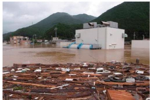
写-1 堤防からの越水により浸水した機場
