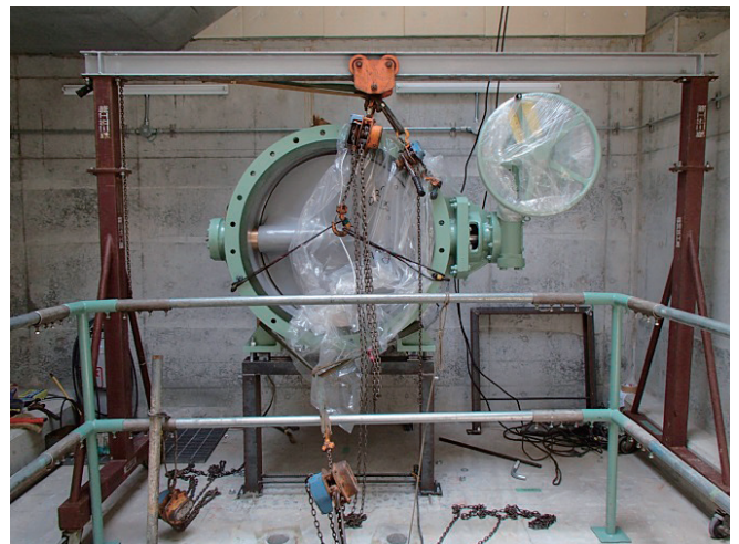
写-4 仮設移動式門型クレーン設置
