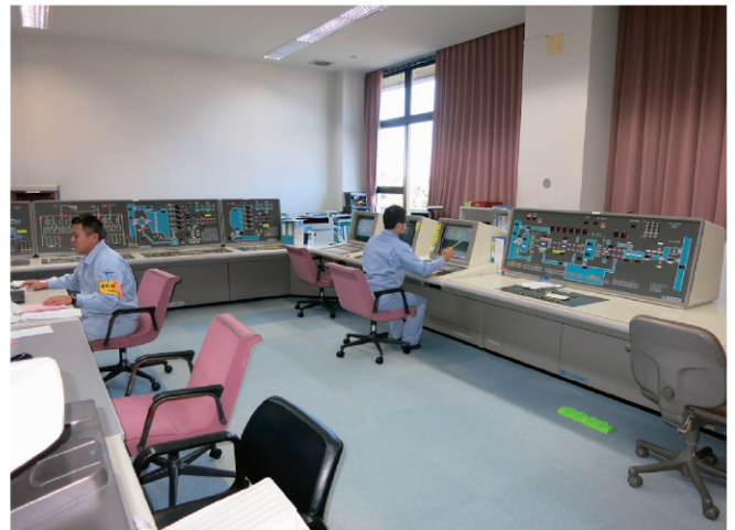
写－6 北千葉揚排水機場操作室
