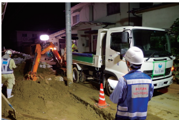
地元建設業者と連携した土砂撤去（広島市、8月）
