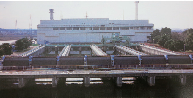
写－1 北千葉揚排水機場
