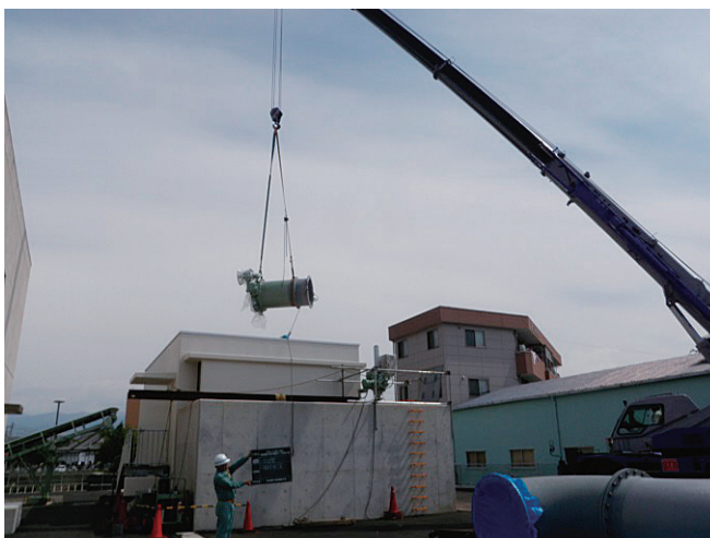
写-3 機器搬入状況
