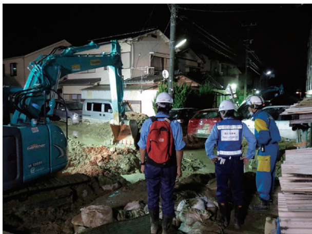
地元建設業者の協力による道路啓開状況（広島市、8月）
