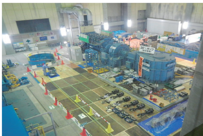
写-10 原動機分解整備状況
