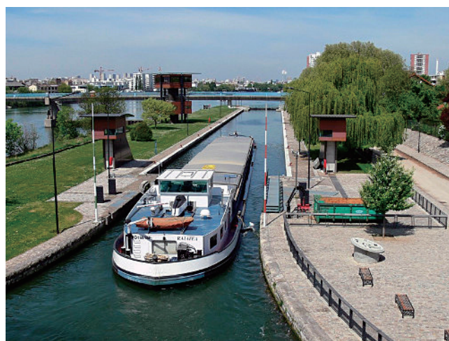
写－5 下流側閘門（船舶通過時）
