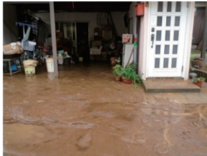
家屋浸水状況
