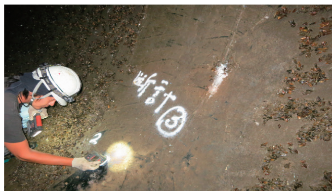
写－18 内面塗装厚計測
