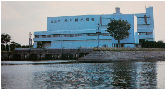
写－5 松戸排水機場
