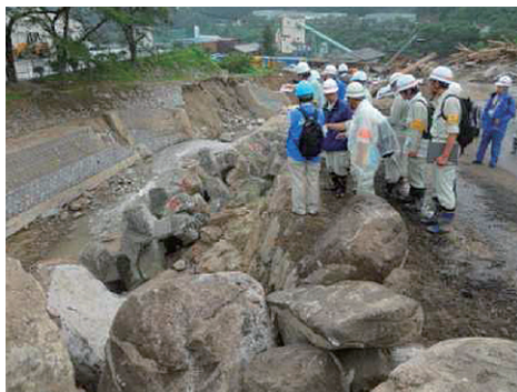
災害復旧技術専門家による調査状況（長野県南木曽町、7月）
