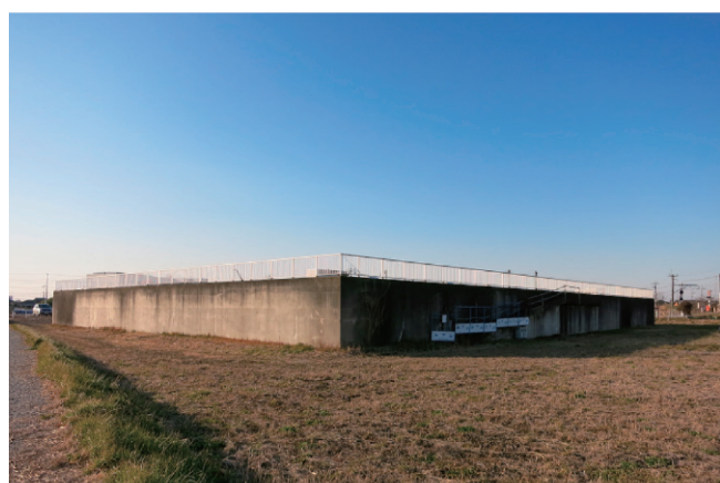
写-12 第一サージタンク
