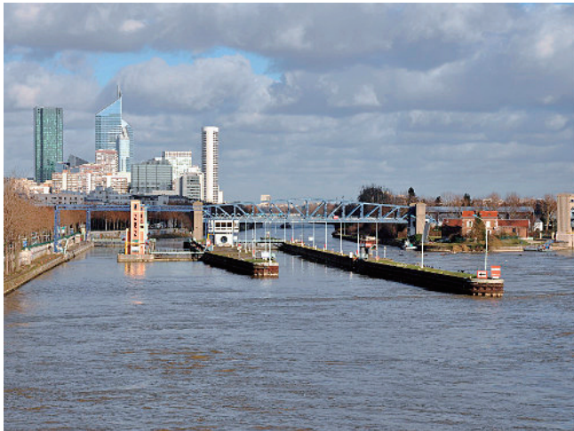
写－7 シュレンヌ閘門上流側からの全景
