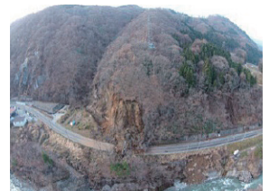
国道148号土砂崩落
