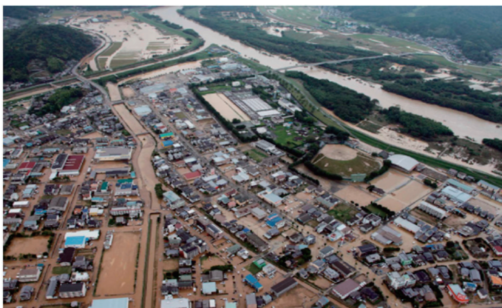
写－1 平成26年8月 京都府福知山市街地の浸水状況
