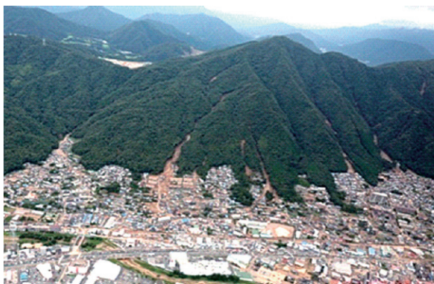
広島土砂災害 八木地区（広島県広島市、8月）
