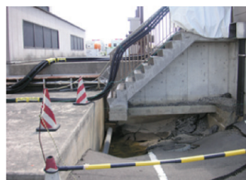
写－10 機場周囲の被災事例 (東日本大震災)
