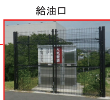
写－7 機器の高設置化 (燃料給油口の高所設置)
