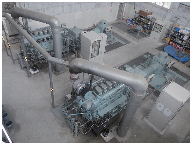
写－ 3 排水機場内状況
