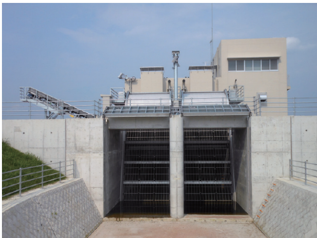
写－１ ほたる川排水機場外観
