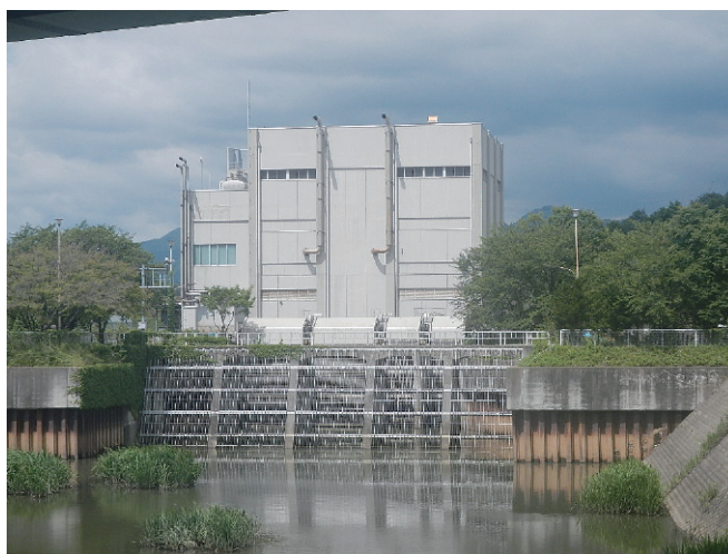
写－9 篠井川排水機場全景（篠井川側より望む）
