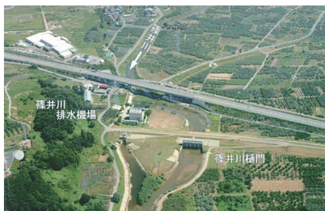
写－1 篠井川排水機場周辺
