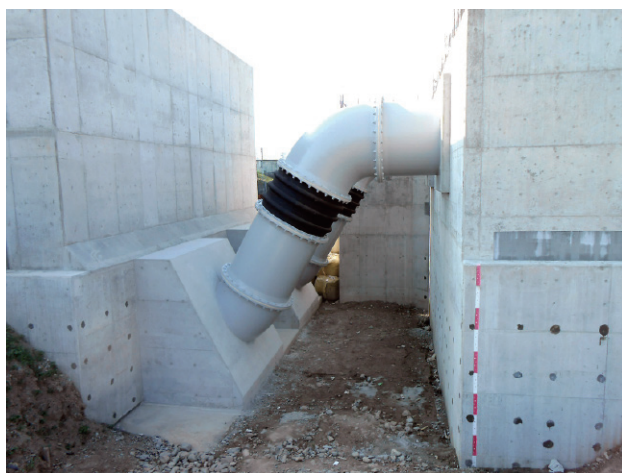
写-3 吐出管埋設部
