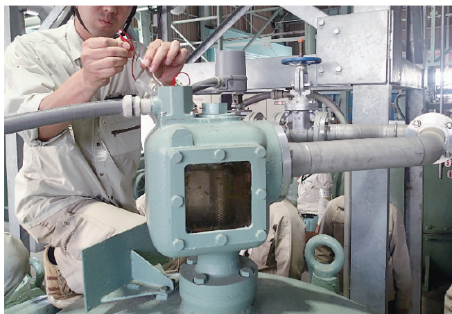
写－2 満水検知器故障時の接点短絡作業
