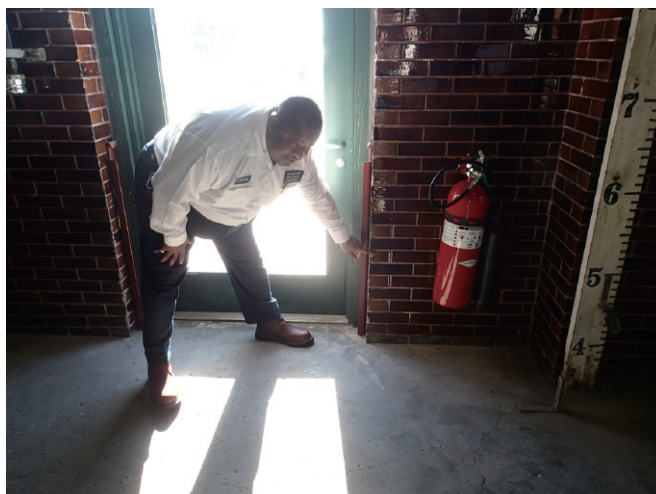
写－9 第1ポンプ場 浸水レベル
