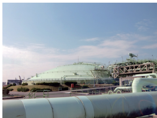
LNG 地下貯蔵タンク
