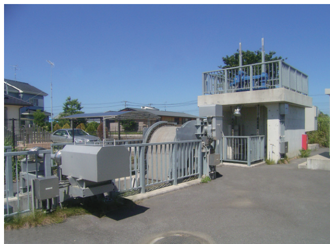
宮原排水機場
