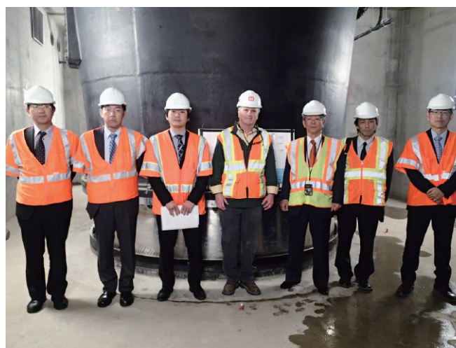
写－5 立軸軸流ポンプ
