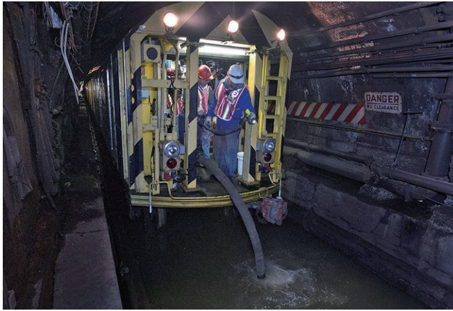
写－17 ポンプ列車外観（出典：MTA）
