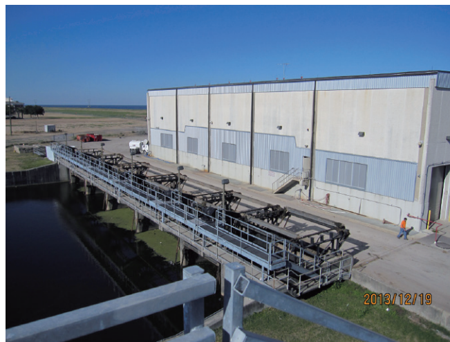
写－12 第4ポンプ場
