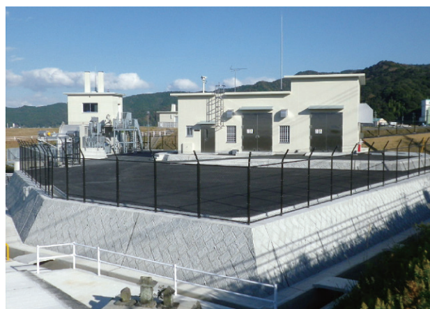
写ー1 蛇崎排水機場全景（上流側より）
