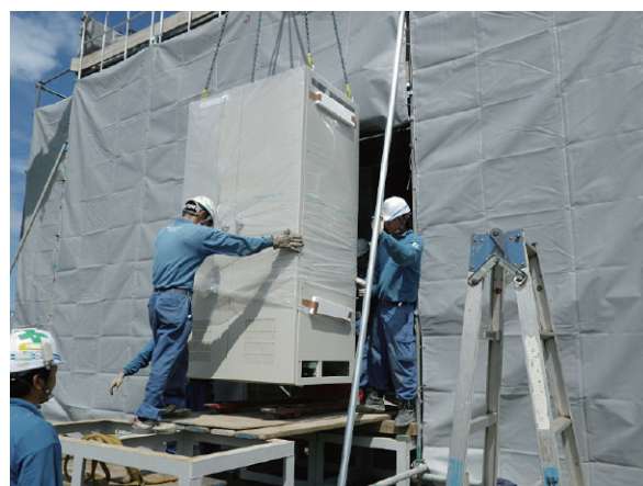
写－12 操作盤搬入状況 (電気室)
