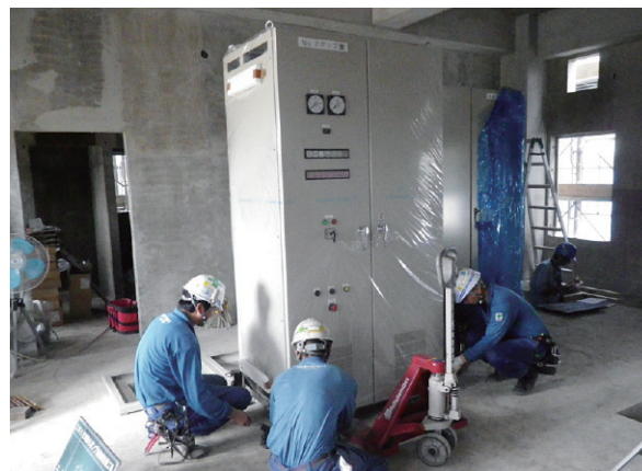
写－13 操作盤据付状況 (電気室)
