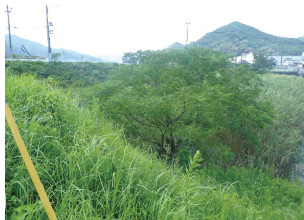
写ー3 蛇崎排水機場着工前（下流側より）
