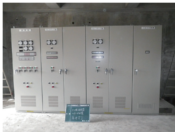
写－14 操作盤据付完了 (電気室)
