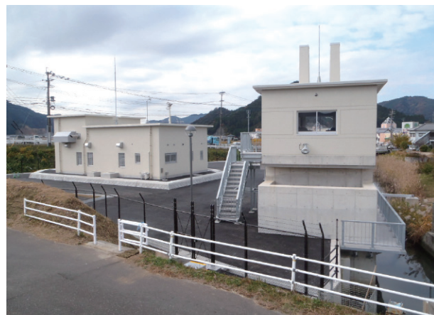
写ー2 蛇崎排水機場全景（下流側より）
