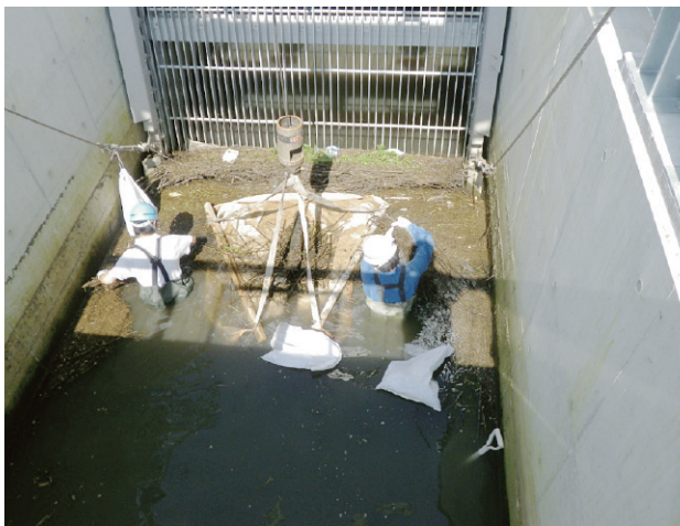
写－15 塵芥除去状況（クレーン車）
