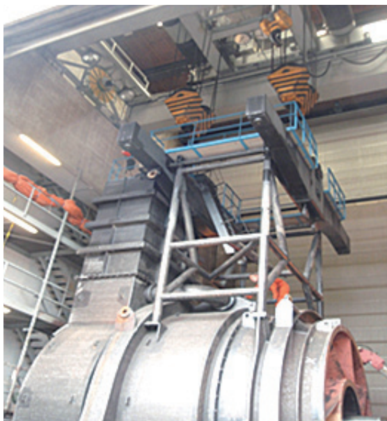
写－7 主ポンプ本体外観
