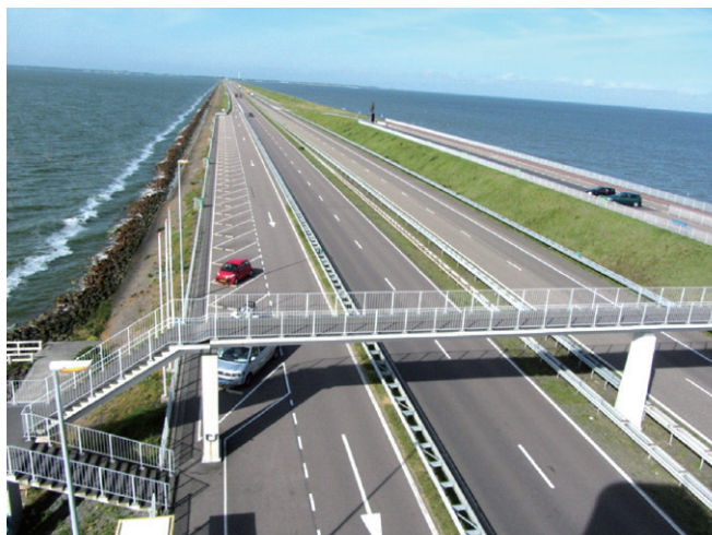
写－8 大堤防に建設された高速道路
