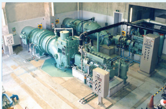
写真左:減速機搭載型立軸ポンプ
