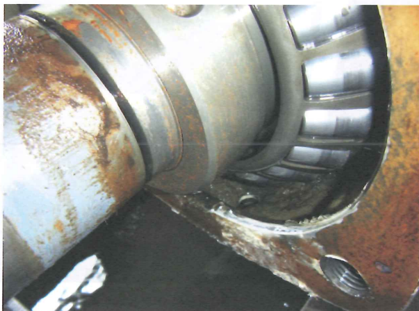
写-7 主ポンプ外軸受内部の砂除去前
