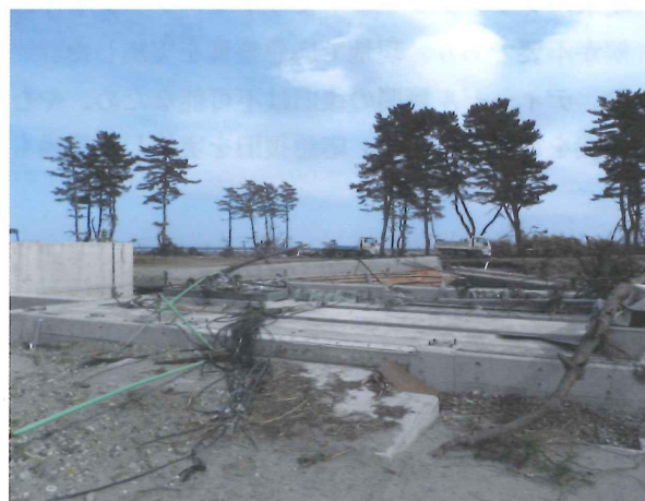
写－1 機場全景 (上屋が流失し、下部構造物のみが残った。)
