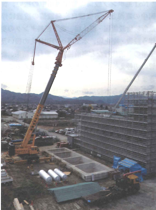
図－10 \phi 1800 主ポンプ据付状況
