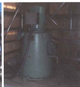
写-10 小ポンプに仮小屋を設置
