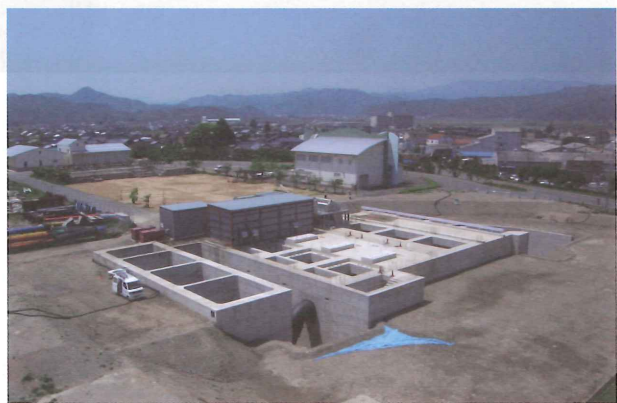
図-8 新設機場躯体構築
