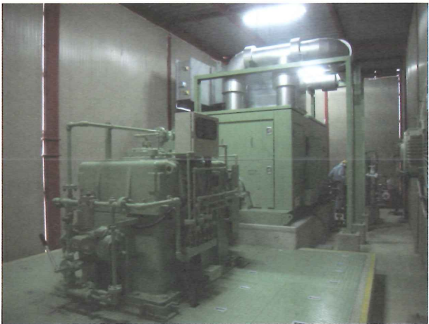
図－5 空冷ディーゼル機関と空冷歯車減速機
