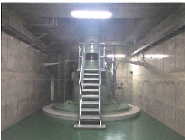
図－11 \phi 1800 立軸斜流ポンプ
