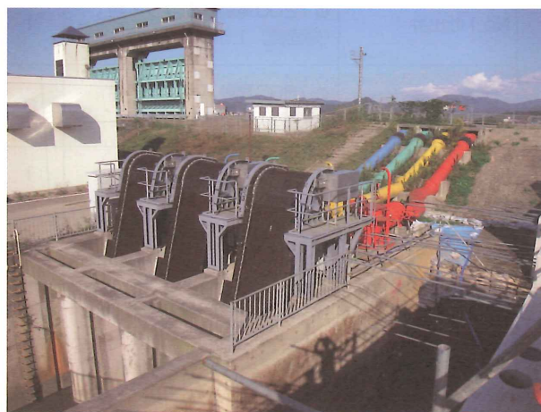
図-2 旧八代排水機場全景
