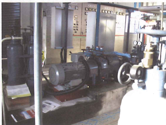
写-10 復旧状況（エンジ基礎上に電動機を据付）
