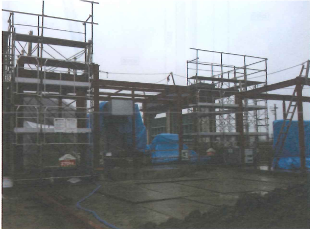
図－6 仮設上屋設置
