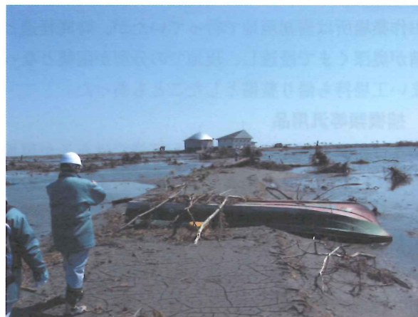
写－1 排水機場への進入道路
