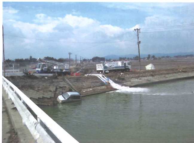
写-6 東日本大震災における被災地での排水状況
