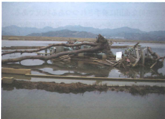
写-1 水没し接近できない機場
