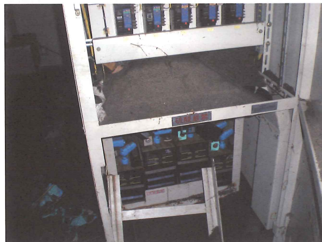
写－6 盤内に大量の砂が堆積
