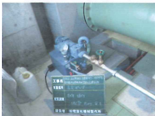
写－11 代用補機の設置
