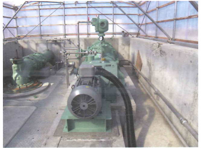
写－5 応急復旧後のポンプ設備
