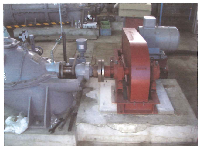
写-3 主電動機を汎用品に交換 (仮設電動機とベルト駆動変速で仮復旧)
