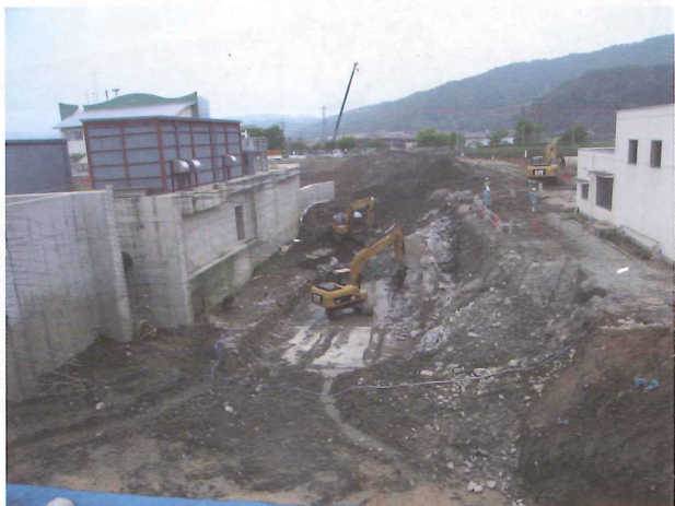
図-7 旧排水設備の撤去
