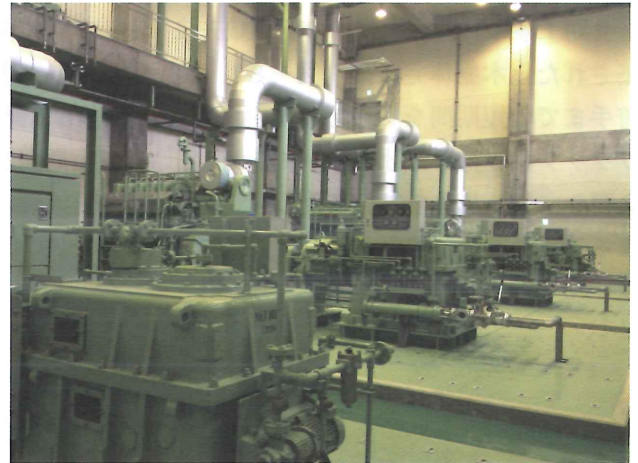
図－12 原動機室据付状況
