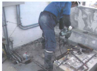
写－12 代用補機に合わせるため基礎改造
