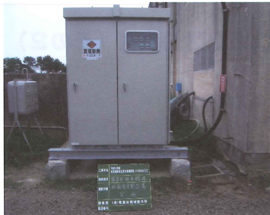
写-8 高圧受電盤のリース品設置
