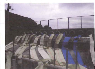
写－ 19 排水ポンプ車の設置状況②
