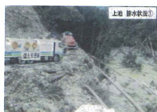
写－25 排水ポンプ車の設置状況
