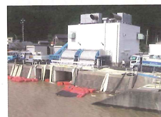
写－ 18 排水ポンプ車の設置状況①
