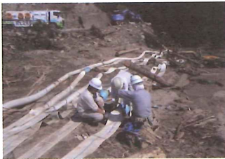
写真-26 排水ホースの敷設状況
