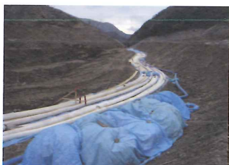
写－22 排水ホース敷設状況
