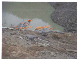
写－20 排水ポンプ設置状況
