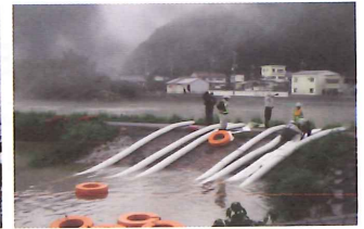
写－ 13 排水ポンプ車による排水作業
