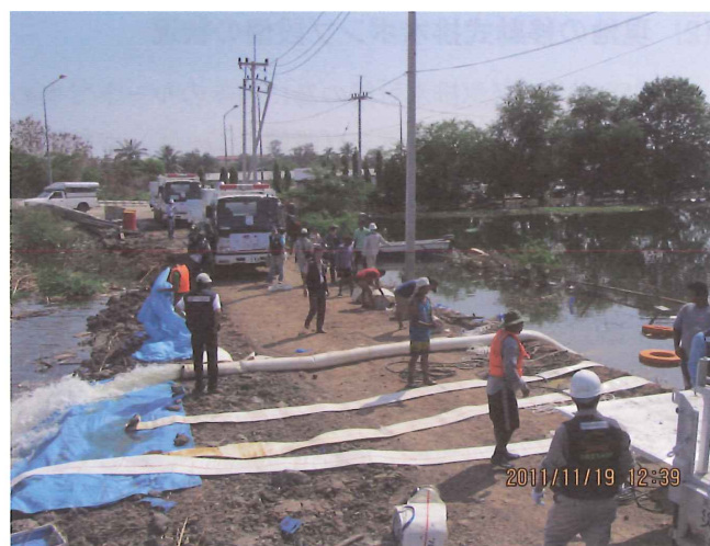
写-1 ロジャナでの排水準備、試運転
