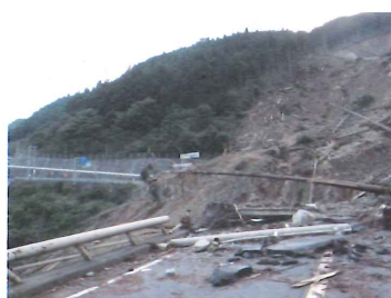
写－1 川上村迫（国道169号）
