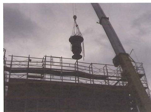
写真-7 主ポンプの搬入状況
