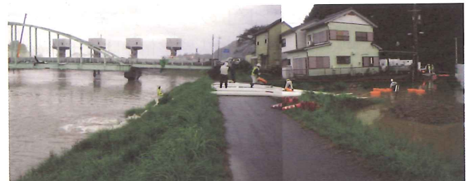
写－ 14 排水ポンプ車による排水作業（鮎田地区）
