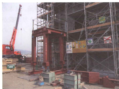
写真-6 搬入架台
