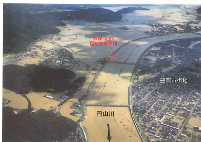
図－3 平成16年10月（台風23号）洪水
