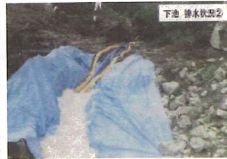
写真-27 排水状況
