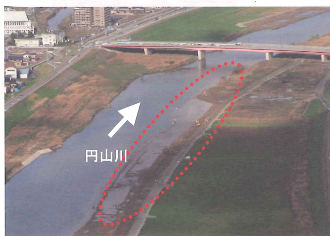
図－4 円山川激特事業における河道掘削 （高水敷掘削による湿地創出）
