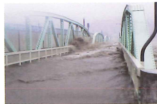
写－ 12 旧熊野大橋からの堤防越水
