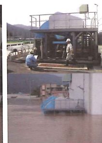
写－ 16 相野谷川排水機場の浸水②
