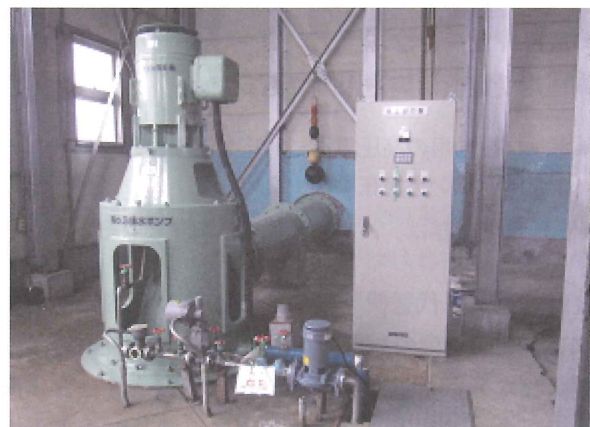
写一 10 仮設の動力盤による応急復旧
