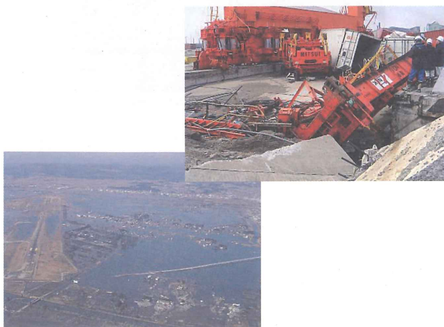
仙台空港浸水状況 仙台塩釜港被災状況
