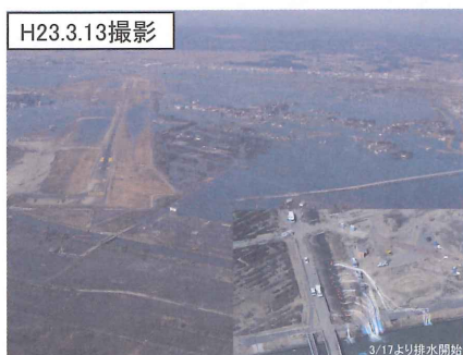
① 仙台空港周辺の排水状況
