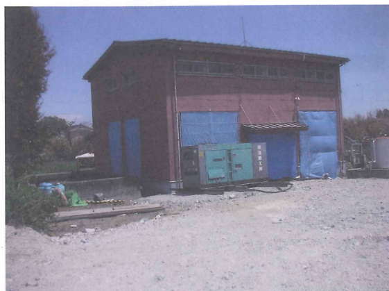
写-11 可搬式発電機で被災機場の電力確保
