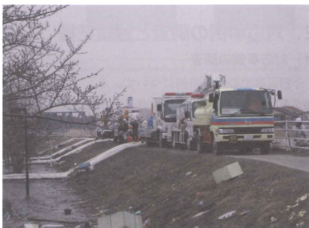
排水ポンプ車への燃料供給状況
