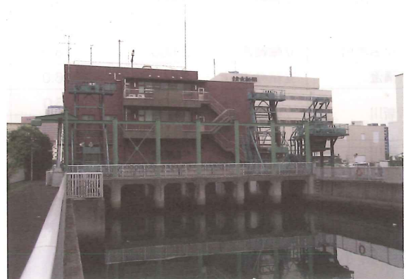
写-9 清澄排水機場
