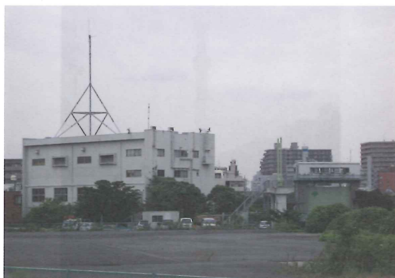
写-11 内川排水機場と内川水門
