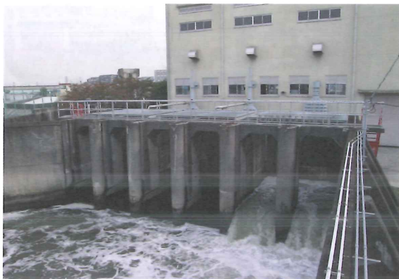
写-10 新川排水機場
