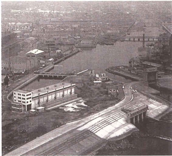
写-5 建設当時の小名木川排水機場
