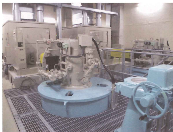
写-1 ポンプ場内全景
