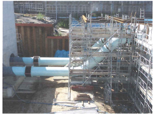
写一5 据付状況
