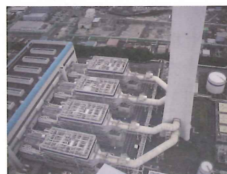
写真2 廃熱回収ボイラと排気塔
