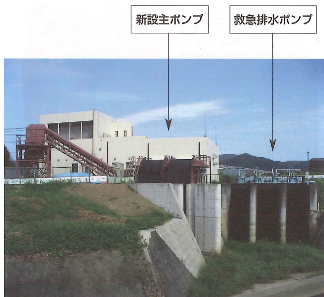
図-5 小坂排水機場全景
