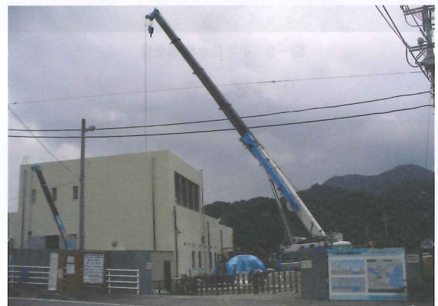
図一14 機器搬入状況
