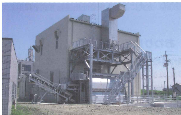
図-19 消音器架台
