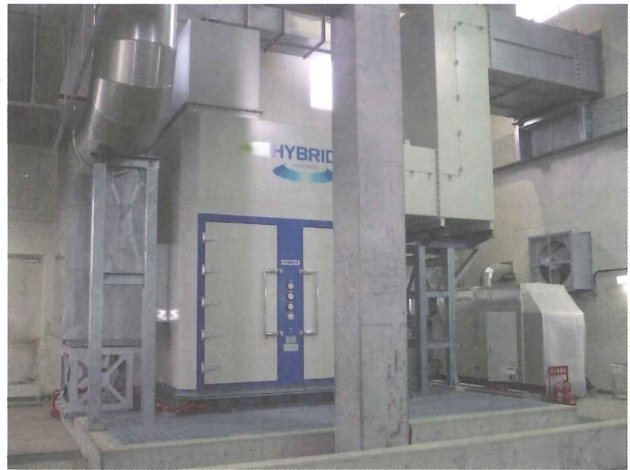
図-10 立軸ガスタービン
