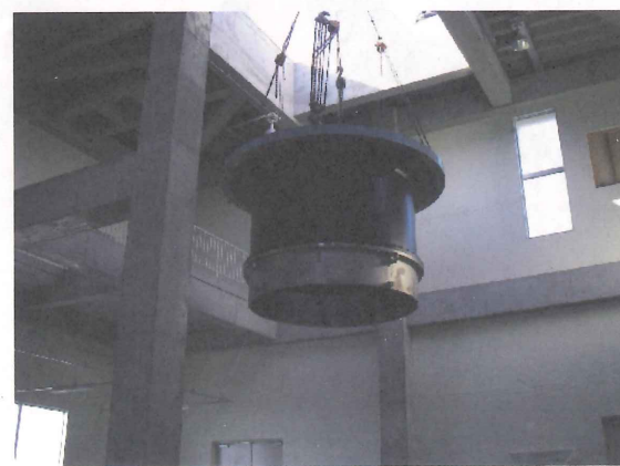
図-18 ポンプケーシングの機場内への吊り込み
