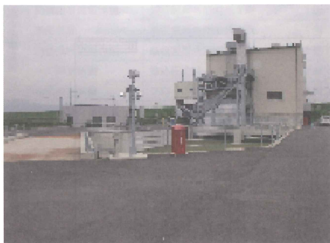
図-6 角ノ瀬排水機場全景
