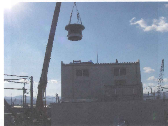
図-17 クレーンによる吊り込み
