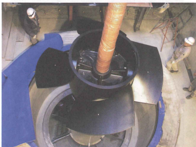
図-9 ポンプ羽根車の組込（現地）
