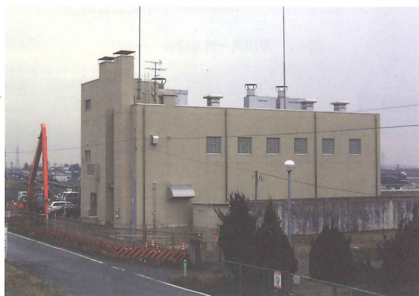
写-8 犀川統合排水機場
