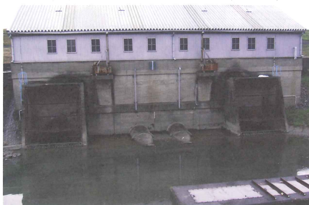
写一6 高水用吸水口と低水用吸水管
