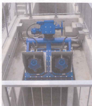
松山市役所殿納め 土居排水ポンプ場 ピアレス型ゲートポンプ(超低水位対応)φ400×15kw×2台
