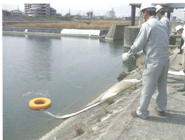
写一九 着水・離脱の状態
