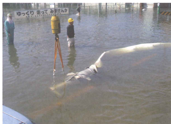
写－1 高潮被害における排水ポンプの設置
