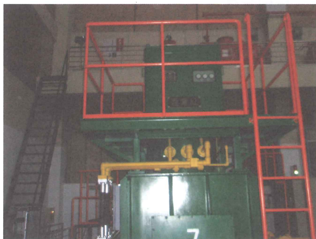
写－4 玉成ポンプ所
