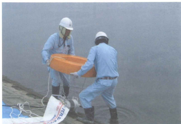
写-2 排水ポンプの投入（訓練時）
