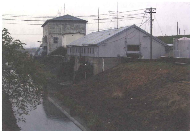
写一3 犀川第一、第二排水機場（後方）
