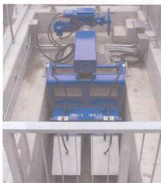
松山市役所殿納め 土居排水ポンプ場 ピアレス型ゲートポンプ(超低水位対応)φ400×15kw×2台
