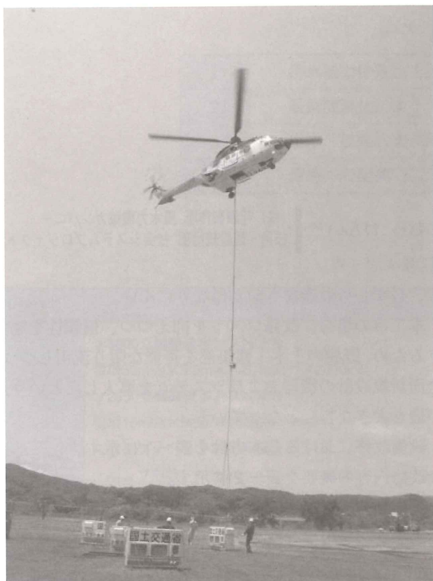
写真-5 ヘリコプターによる運搬状況
