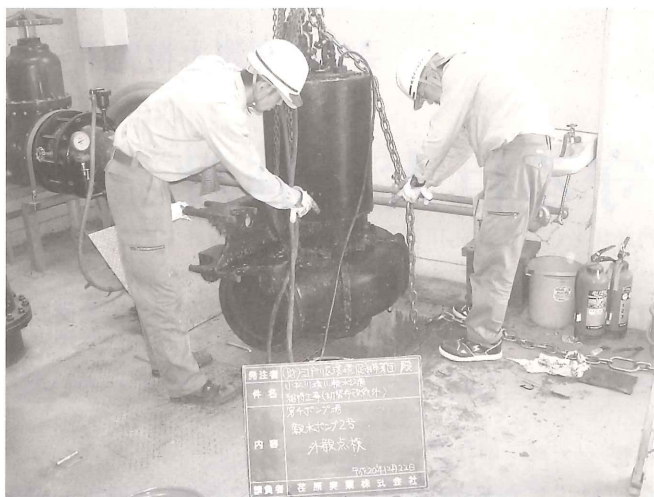
写-3 ポンプ引上げ点検
