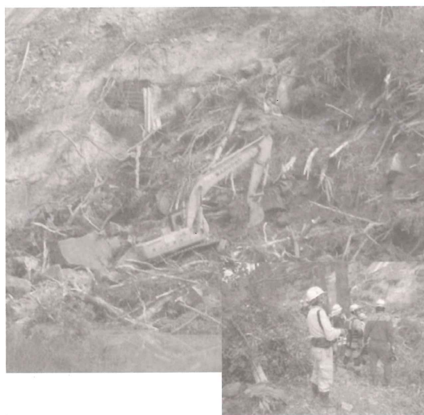
写真一2 遠隔式BHの稼働状況 (宮城県栗原市花山中村地区)
