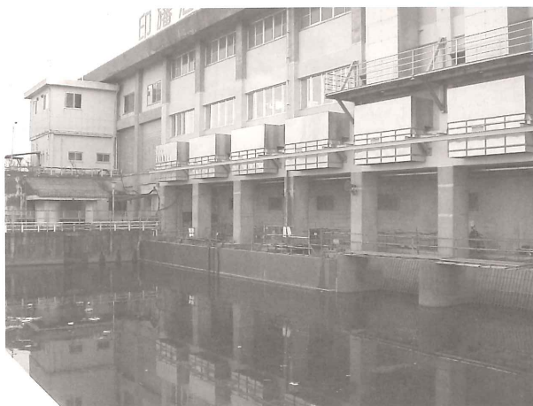
吸込側の仮止水設備／上流側
