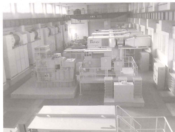
改修後のポンプ室内全景
