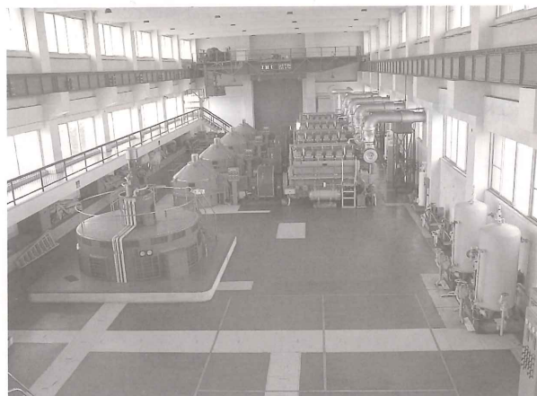
改修前のポンプ室内全景
