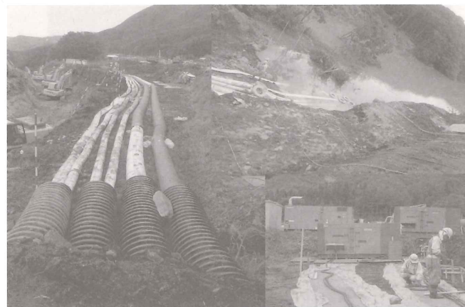
写真-3 ポンプ設置状況 (岩手県一関市市野々原地区)
