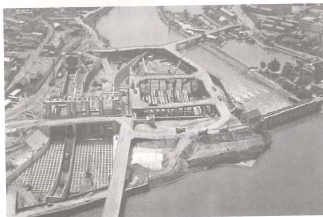
写一2 工事中の毛馬排水機場（中央）と毛馬水門・毛馬閘門（左）
