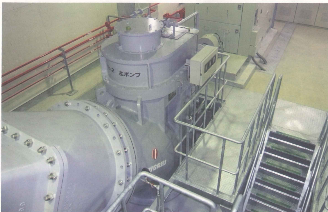
国土交通省 四国地方整備局/大津田排水機場納入(サイフォン式 排水機場) 仕様: 1350\text{mm} \times 5\text{m}^3/\text{sec} \times 2.72\text{m} \times 240\text{kW} 2台
