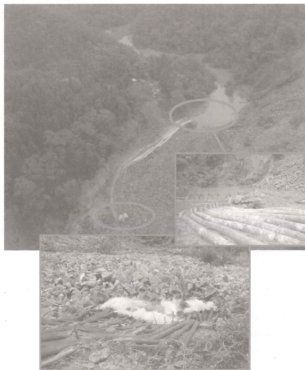
写真-4 ポンプ設置状況 (宮城県栗原市湯ノ倉温泉地区)
