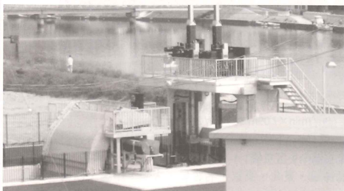
国土交通省 中国地方整備局 出雲河川事務所 殿納め 湯谷川排水施設 ゲートポンプ 横軸 φ1200×2台
