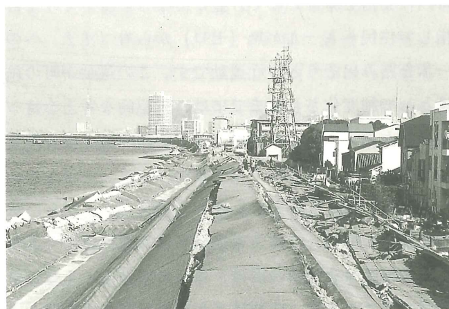
写真1 堤防の被害(平成7年兵庫県南部地震、淀川)
