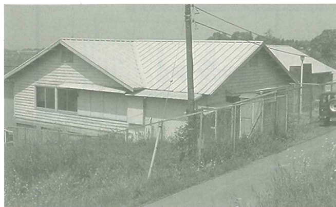
写ー1 機場建家
