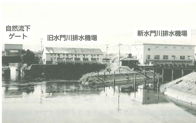
写-1 水門川から機場を臨む
