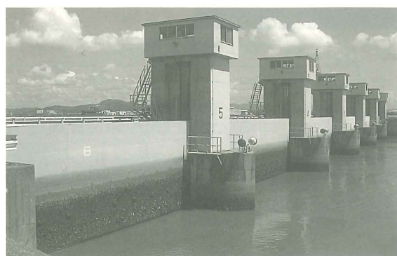
写－3 百間川河口水門（既設）
