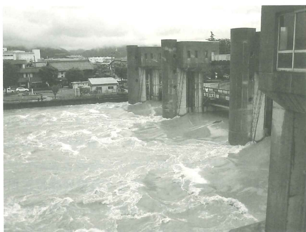
写一1 釜口水門の400m 3 /s放流状況
