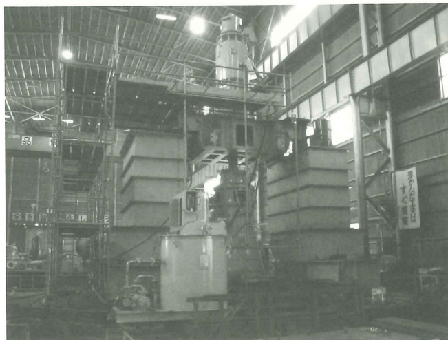
写-4 施工状況②
