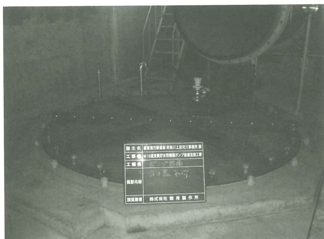
写-3 施工状況①
