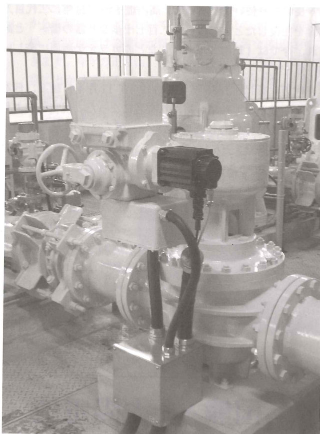
サーボモータ駆動式ロート弁外観
