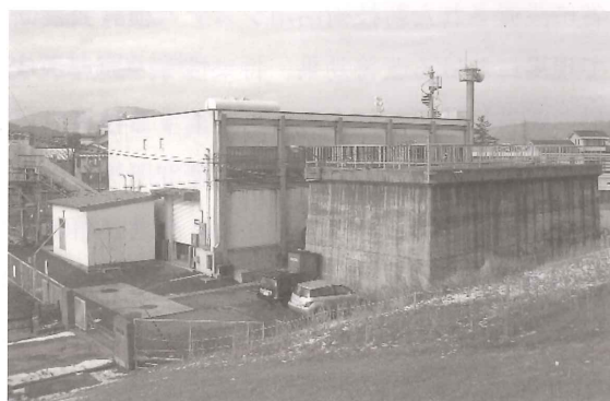
写一 円山川堤防より 豊岡排水機場を望む
