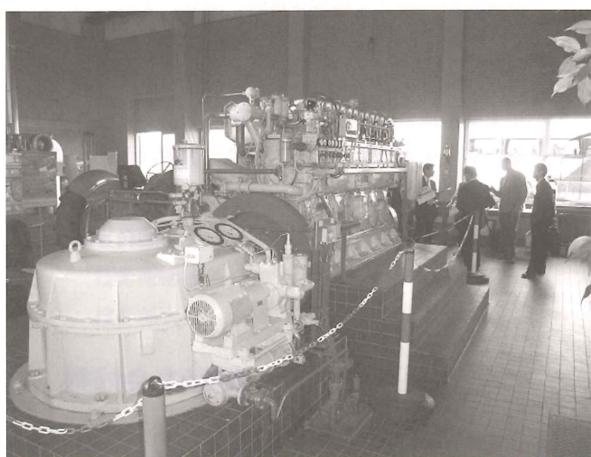
写-7 ジェマールポンプ場
