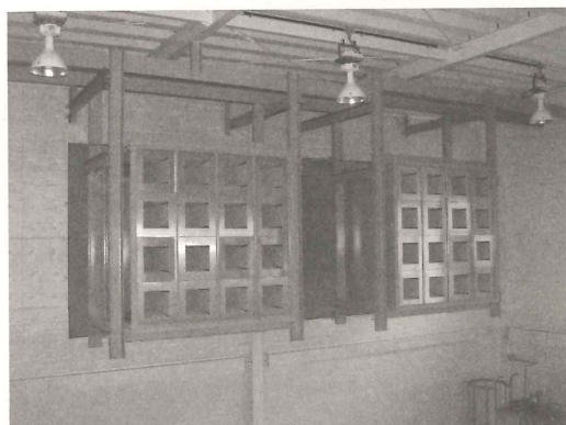
写-2 給気側ユニットサイレンサ（天井より吊り下げ）
