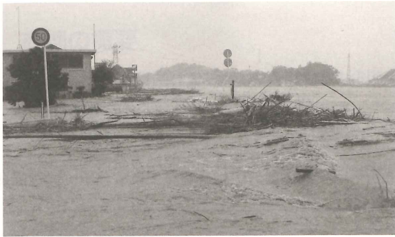
写一 五ヶ瀬川の越水状況（延岡市）
