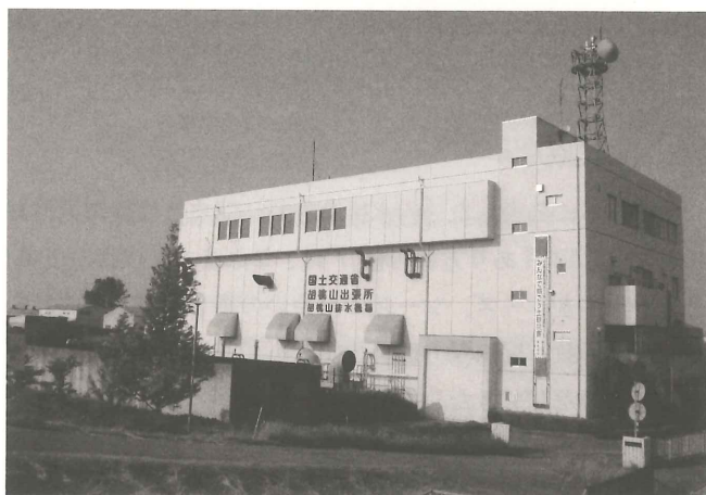
写一 湛水防御の要 胡桃山排水機場
