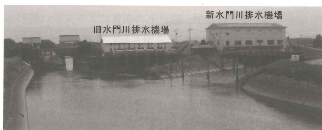
写5-1 旧水門川排水機場 新水門川排水機場
