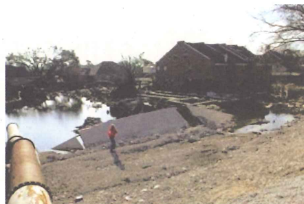
写三 破堤部堤内側の被災状況
