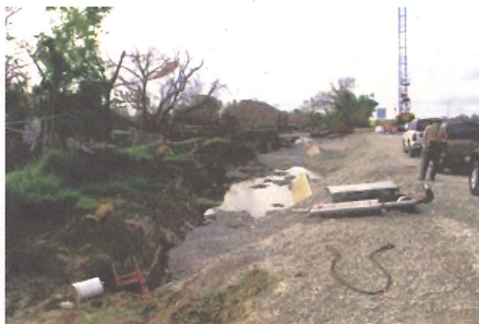
写二 水平に移動した堤防の一部と仮締め切り堤防
