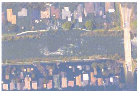
写四 北側左岸破堤地点のfloodwallの状況 (8月31日撮影のNOAAの衛星画像)
