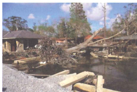
写一七 南側破堤地点の被災状況
