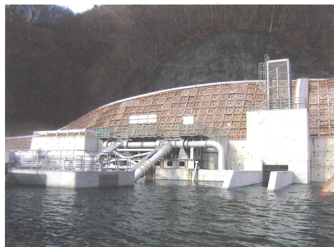
写一2 川治ダム側設備据付状況
