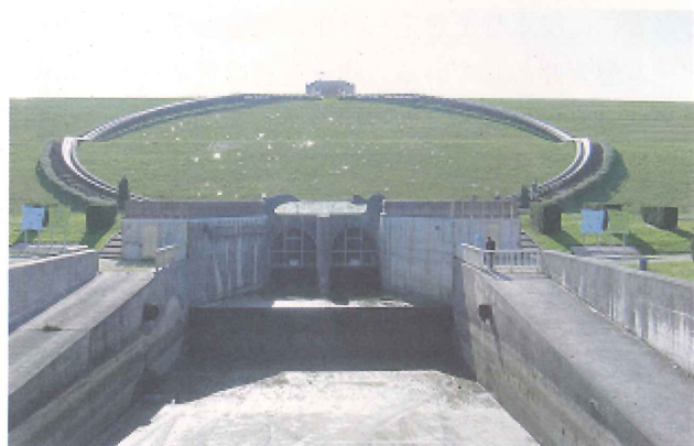
写-1 オーブ貯水池放水路
