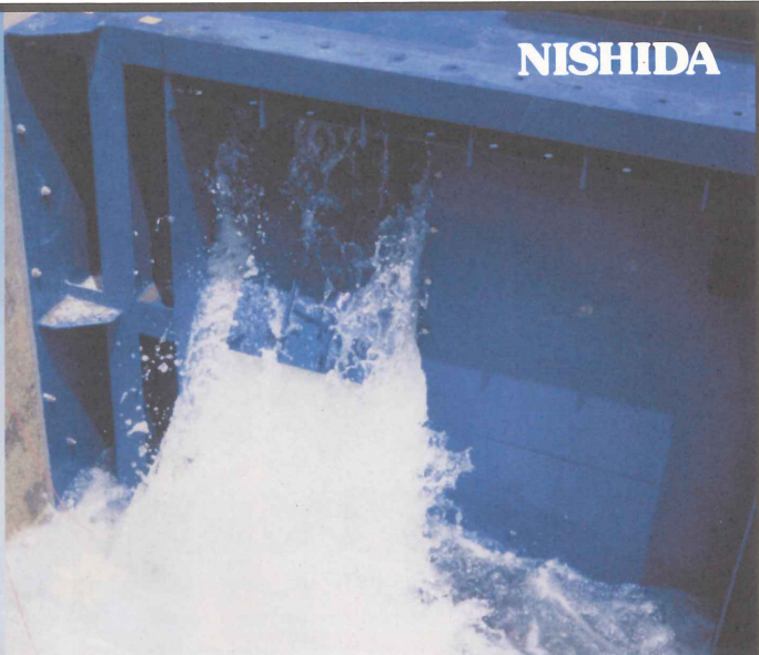
ポンプアップゲート吐出状況
