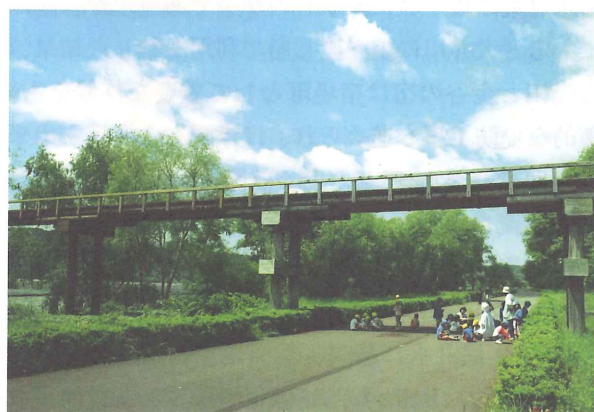
写一6 高水敷利用
