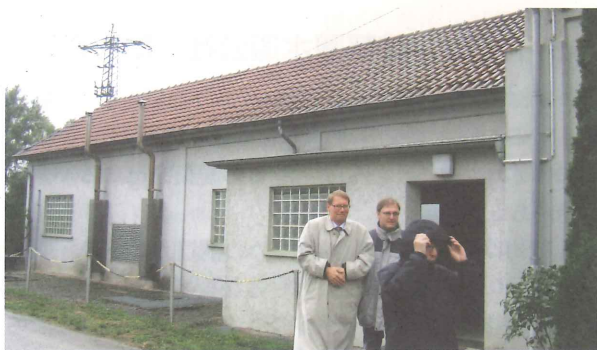
写一4 イゼナッハ=エッグバッハ地区ポンプ場外観写真
