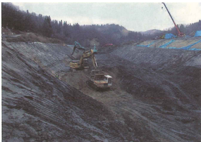
写-6 仮設排水管路施工状況（下流から望む）
