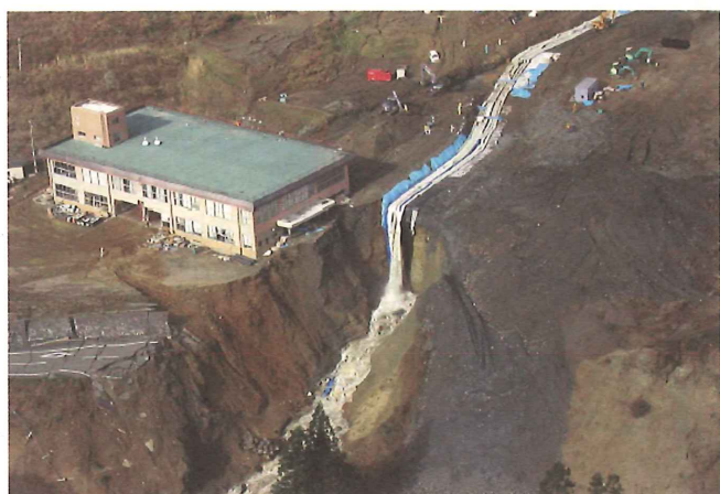
写-4 排水による地盤浸食状況
