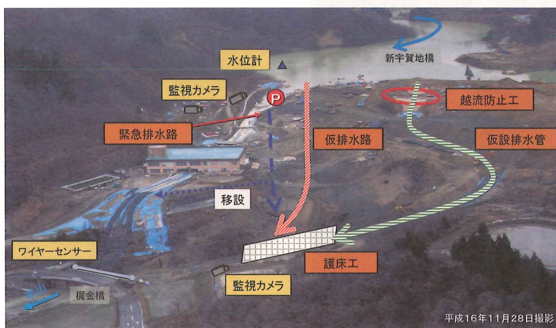
写-3 東竹沢河道閉塞対応状況
