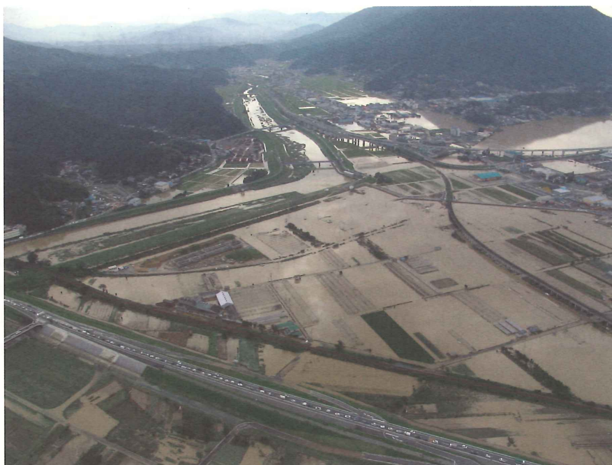
写一4 東大洲浸水状況
