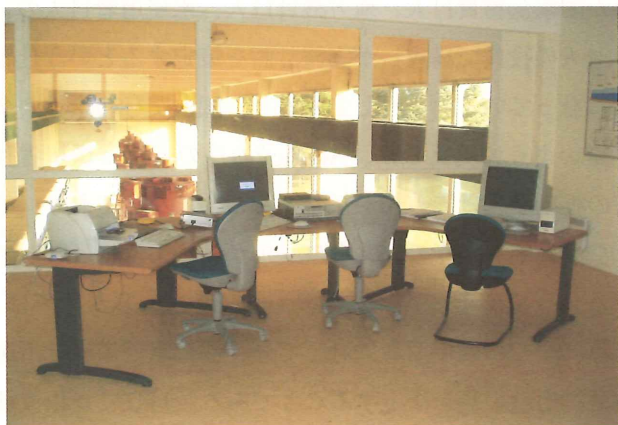
写一 ポンデセ排水機場 中央制御室
