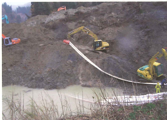
写-9 ポンプ設置作業
