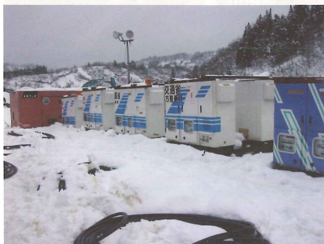
写-8 ポンプの操作盤設置状況
