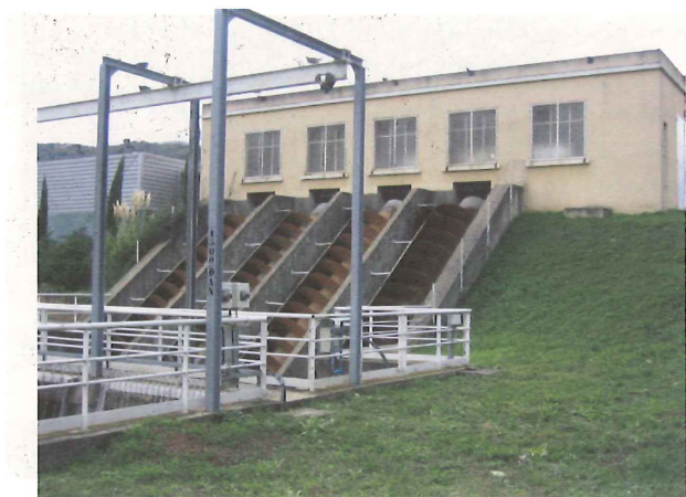
写-2 サンバリエポンプ場
