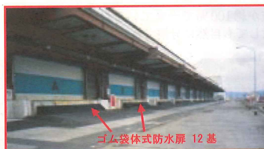
写-4 大規模施工例 漁港水産棟入口 （広島県高潮対策事業）
