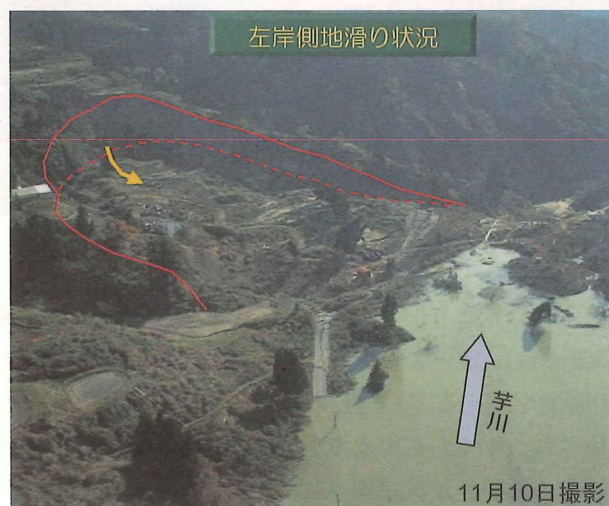
写二 河道閉塞状況（寺野地区）
