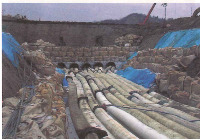
写-5 仮設排水管（呑口）におけるポンプ排水
