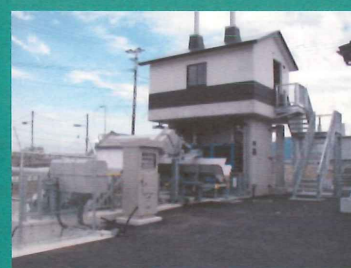
排水機場全景
