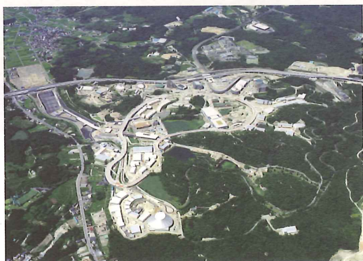
写-1 整備が進む会場の様子(全景)
