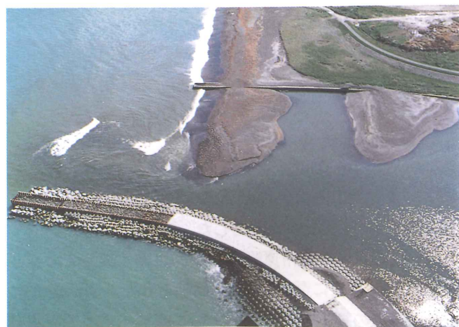
写-2 完成間近の河口導流堤
