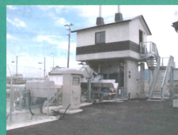
排水機場全景
