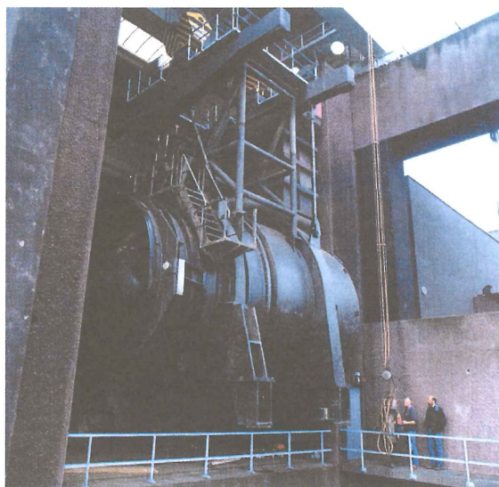
写真1 既設ポンプ吊り上げ状況
