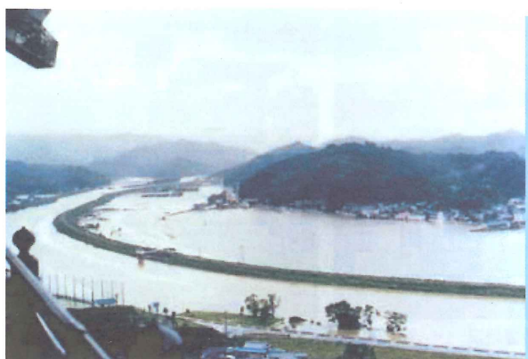
写一1 平成4年8月台風11号による安並地区の浸水被害状況
