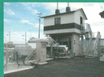
排水機場全景
