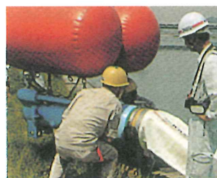
写真3 設置作業状況
