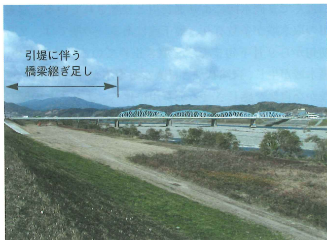
写一3 国道55号線那賀川橋（昭和3年竣工） 昭和10年代の右岸引堤により、既設橋梁の継ぎ足しが行われた。
