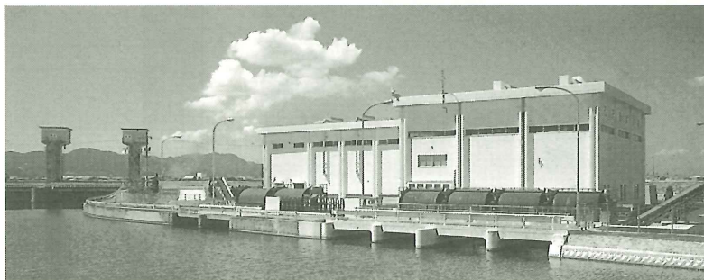
国土交通省 中国地方整備局 乙子排水機場 除塵機設備工事 4.0m×4.97m-4基 4.0m×4.55m-2基 (岡山市)
