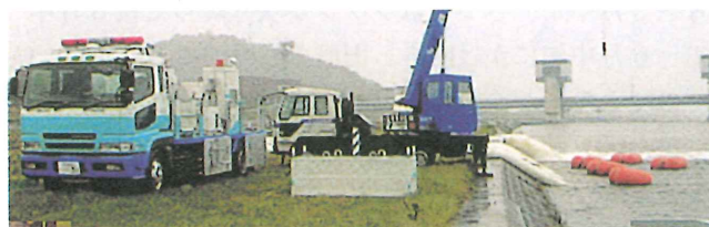
写真2 排水ポンプ車運転状況全景
