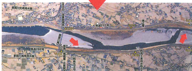
平成13年 写一2 交互砂州の経年変化（那賀川橋付近） 水衝部では局所洗掘が著しく管理が難しい河川である。
