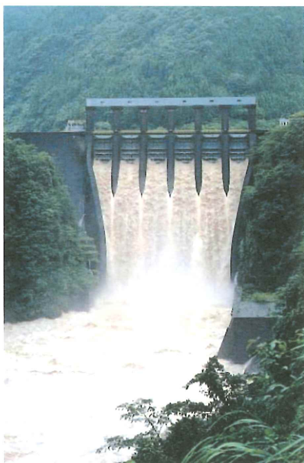
写-4 長安口ダム
