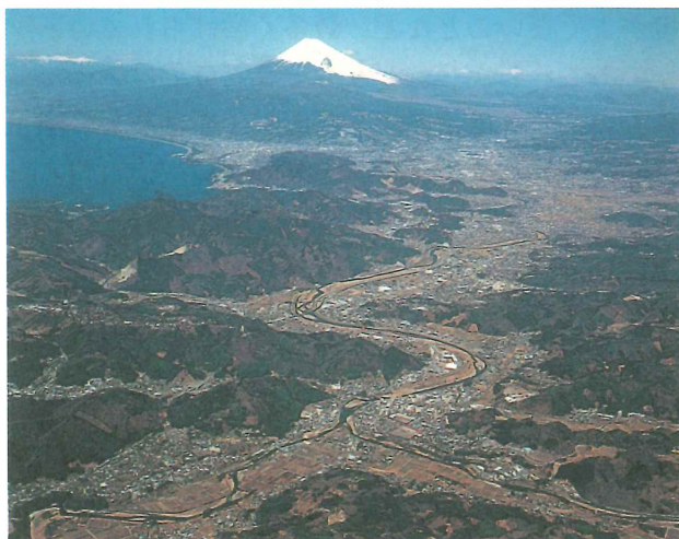
写一 伊豆半島中央部を北上する狩野川
