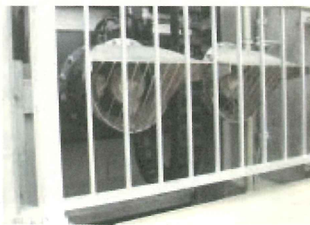
写-3 低水位型横軸ポンプゲート施工例
