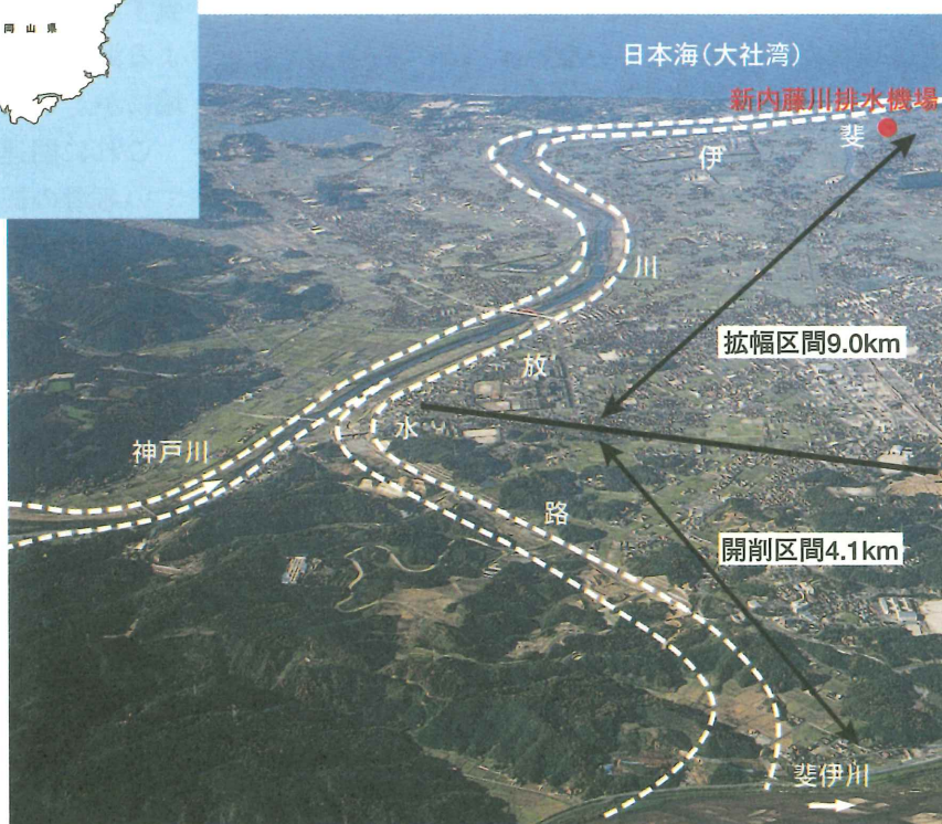
図一1 斐伊川放水路13.1km
