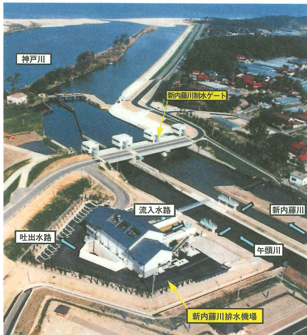
写一1 新内藤川排水機場 全景
