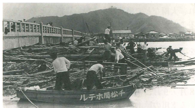
写一5 狩野川台風により発生した流木の除去作業(下流部・永代橋)
