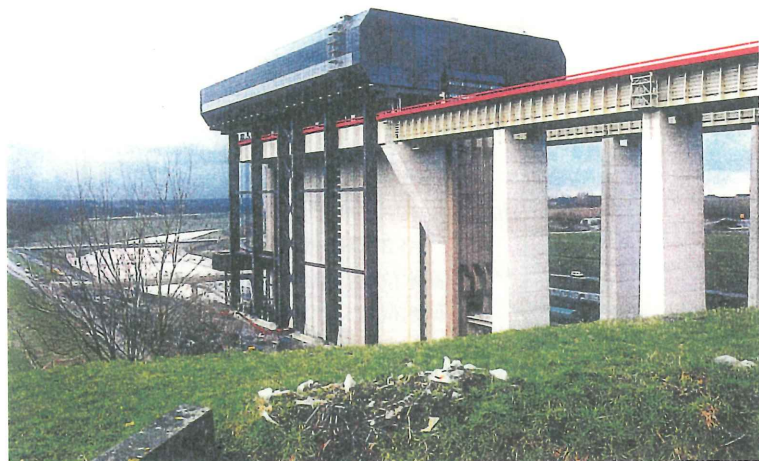
写-1 ストレピ・テューのリフトの全景（後面）
