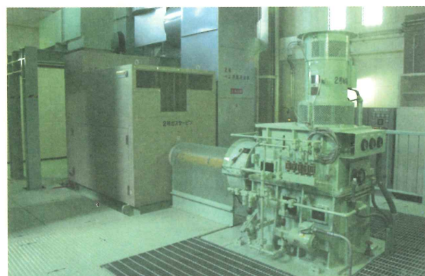
写一3 主原動機（左）及び空冷減速機（右）
