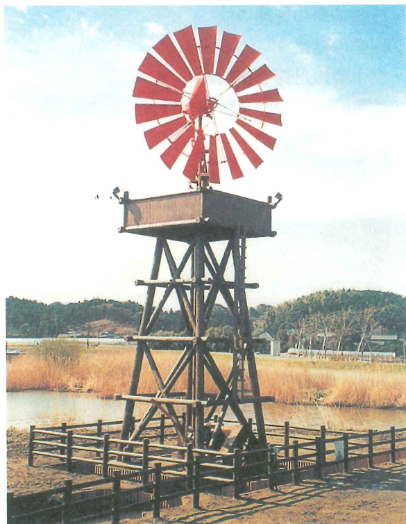
風車による水質浄化システム
