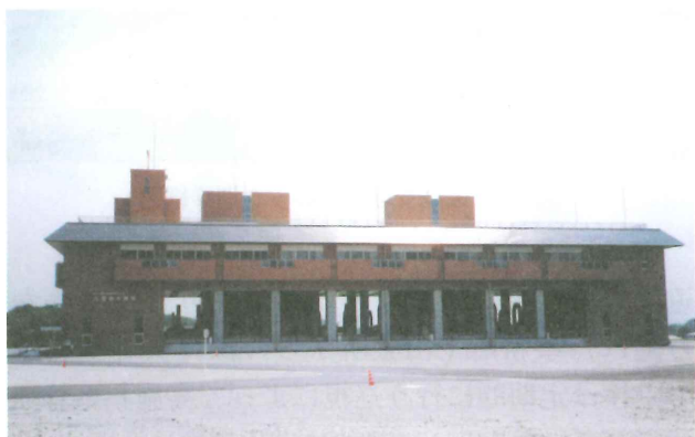
写一 首都圏外郭放水路・庄和排水機場外観
