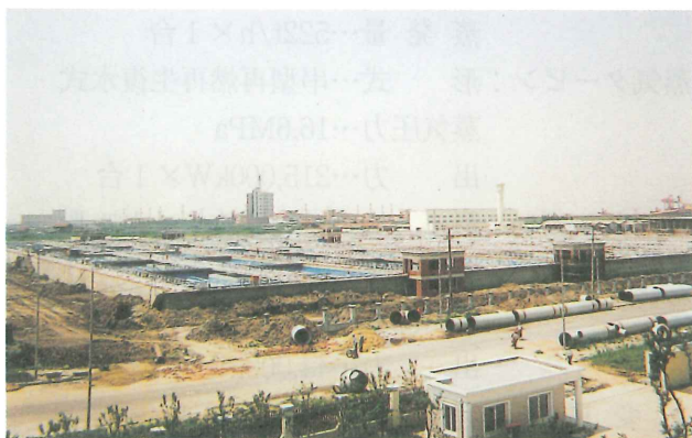
写-8 石洞口都市污水处理場建設現場
