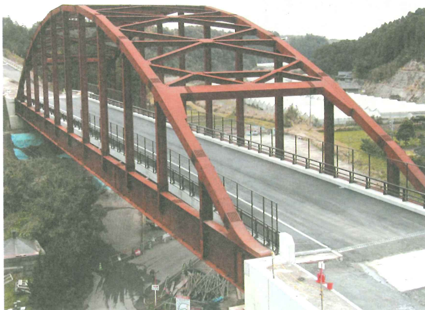
写-4 ランガー橋
