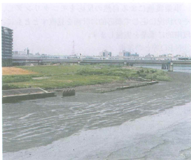
写一4 直立護岸の地上部を撤去した実証試験箇所(東京都江戸川区)
