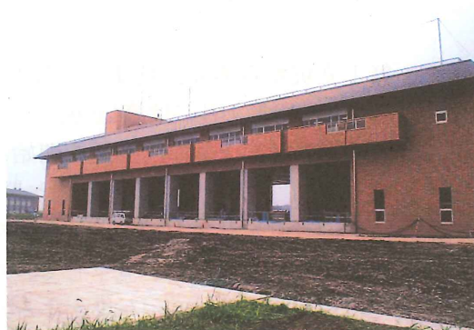
写一4 排水機場 建屋
