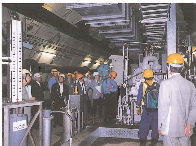
写-1 ポンプ設備見学風景
