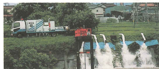
写－3 排水ポンプ車稼働状況
