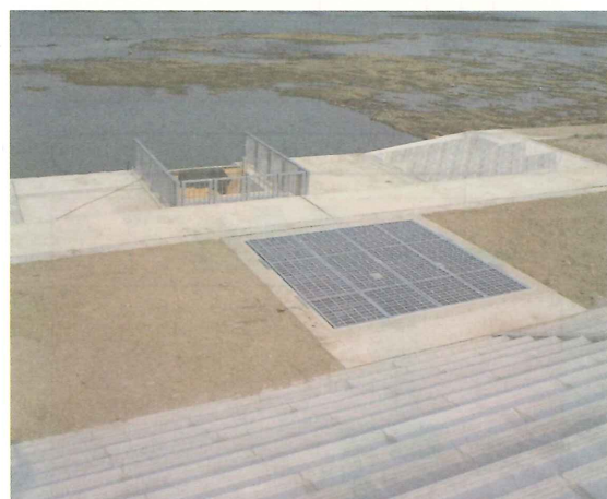
写-2 堤防天端よりゲート設置個所を望む
