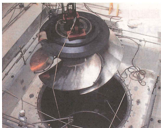
写一5 50m 3 /s 主ポンプ羽根車据付状況
