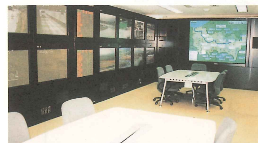
写－4 防災センター (福島工事事務所内)
