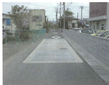
写-1 道路下設置例（平成12年度実施）
