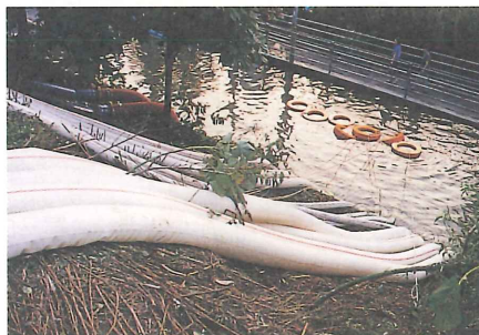
排水ポンプ車(30m³/min)による排水状況新川町地区
