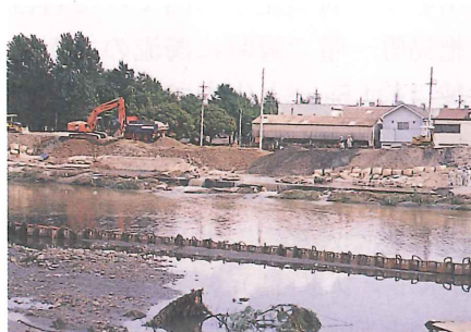
破堤箇所の復旧状況
