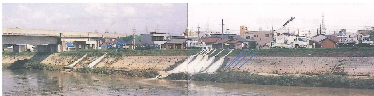
写-2 排水ポンプ車排水状況
