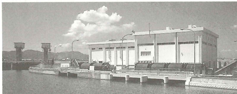
建設省 中国地方建設局 乙子排水機場 除塵機設備工事 4.0m×4.97m-4基 4.0m×4.55m-2基 (岡山市)
