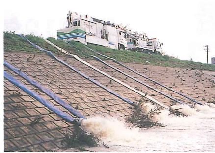
新川左岸丸中橋付近での排水状況
