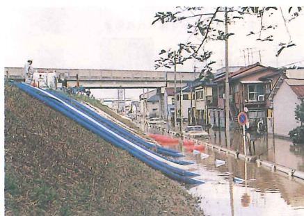
新川左岸丸中橋付近での取水状況
