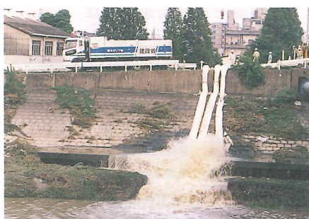
新川への排水状況
