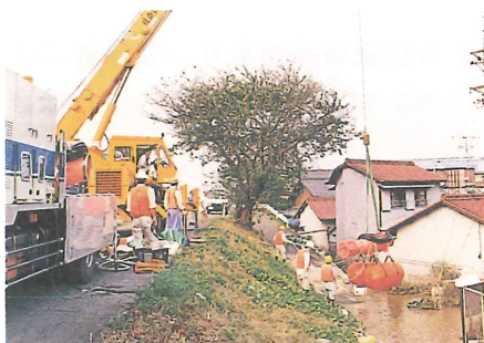
排水ポンプとフロートの設置
