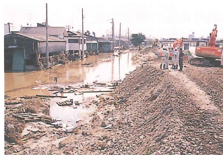
破堤箇所付近の復旧状況
