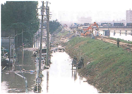
破堤箇所付近の復旧状況、先に見えるのが国道22号
