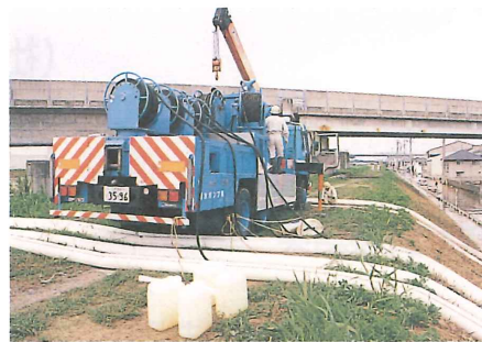
新川左岸丸中橋付近での排水ポンプ車
