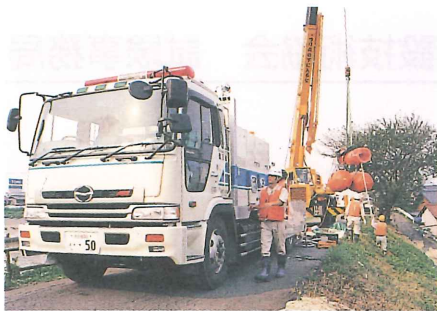
排水ポンプ車とクレーン車による設置状況
