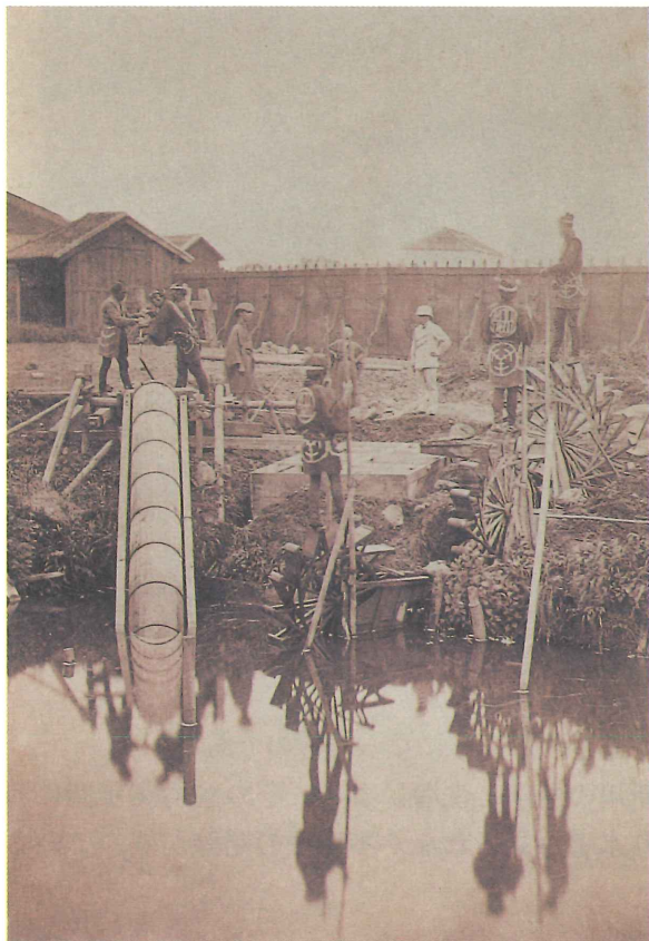
デ・レイケ指導のもと排水ポンプの性能比較の風景 明治17年頃（中央にデ・レイケ?）
