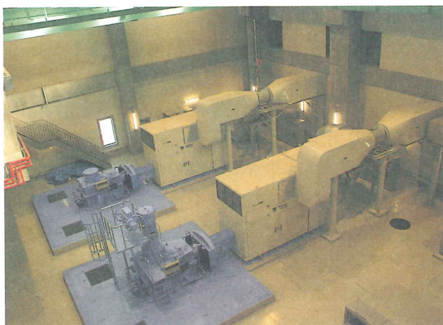
写-3 排水機場内全景
