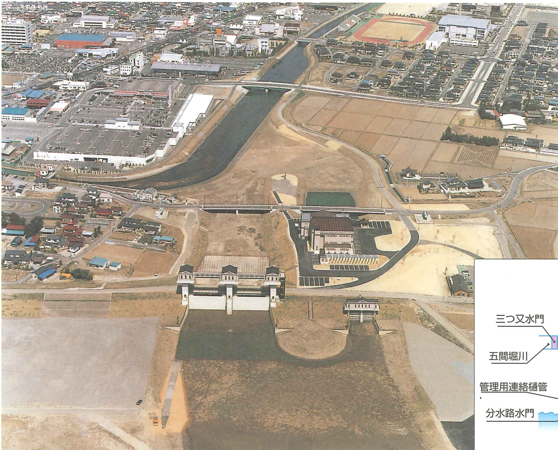
写一1 完成した押分排水機場
