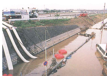
新川左岸丸中橋付近での取水状況
