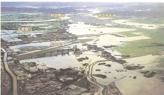
写一2 内水被害状況
