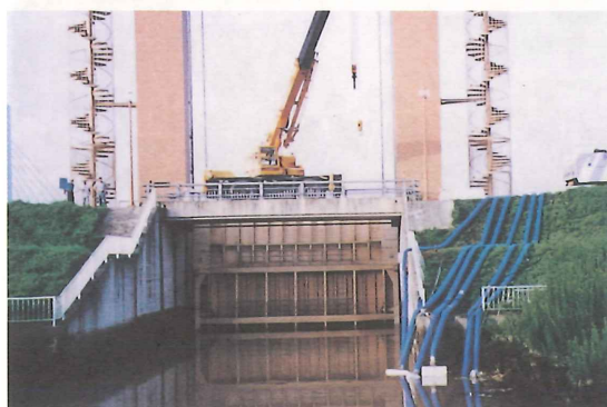
写-2 内川水門での排水ポンプ車の作業状況
