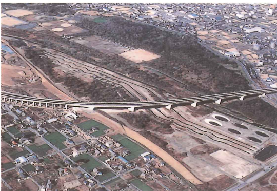
写-4 自然共生研究センター
