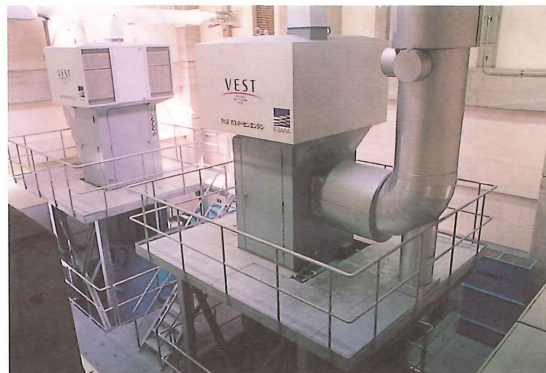
写-2 立型ガスタービン設置状況
