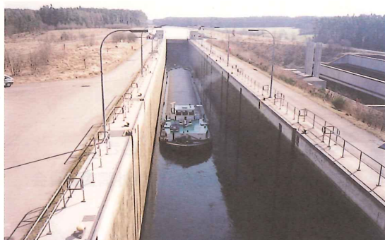
写一2 ヒルボルトシュタイン閘門
