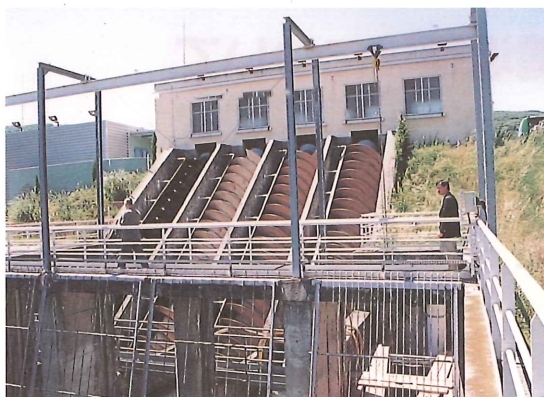
写-7 ポンプ場全景
