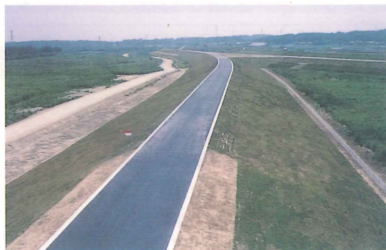
写-3 那珂川右岸21km付近の堤防整備状況
