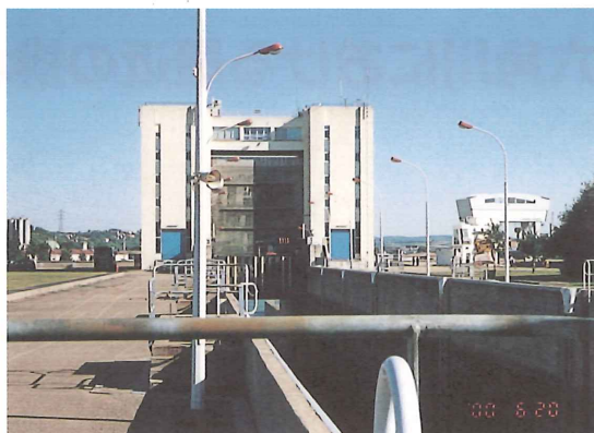
写-8 閘門設備（上流側から撮影）
