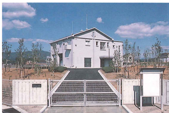
写一 完成した板橋排水機場全景
