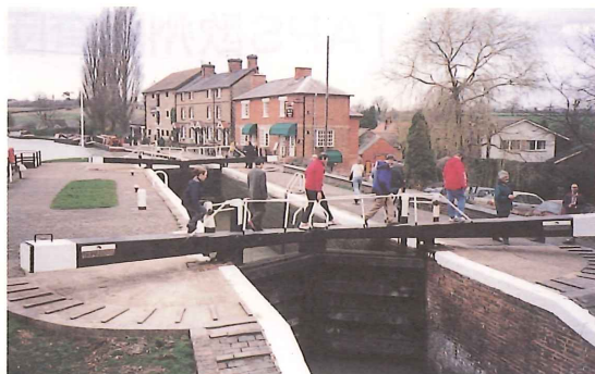
写一4 ノースハンプトンの運河博物館と閘門
