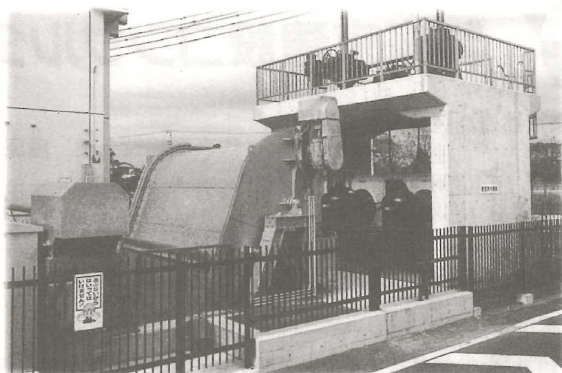
▲龍宮地区排水機場<千葉県>
