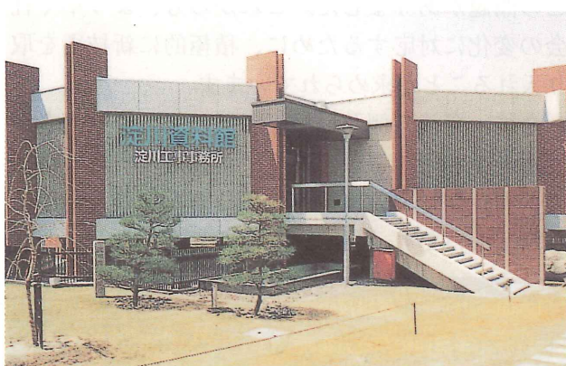
写-1 淀川資料館全景
