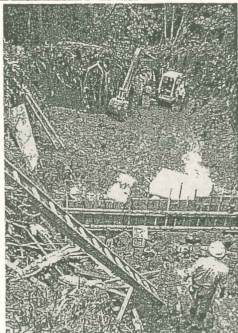
次の雨が降らないうちに、と大急ぎで進む護岸の復旧工事＝美土里町横田で
