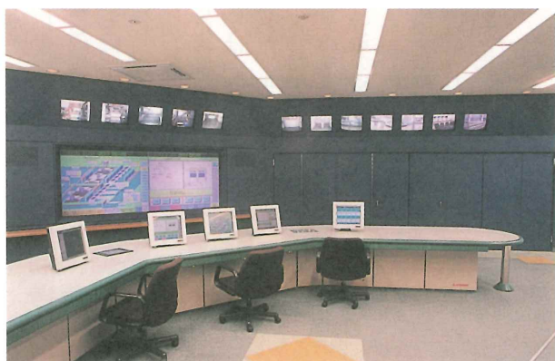
八潮排水機場操作室
