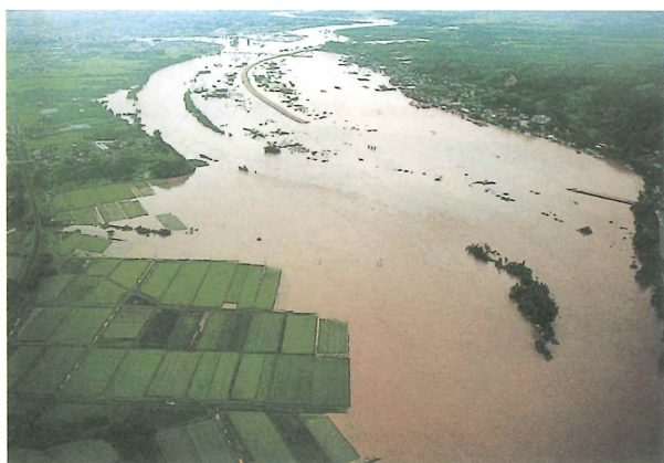
写一1 梁川町五十沢地区浸水状況（築堤箇所）
