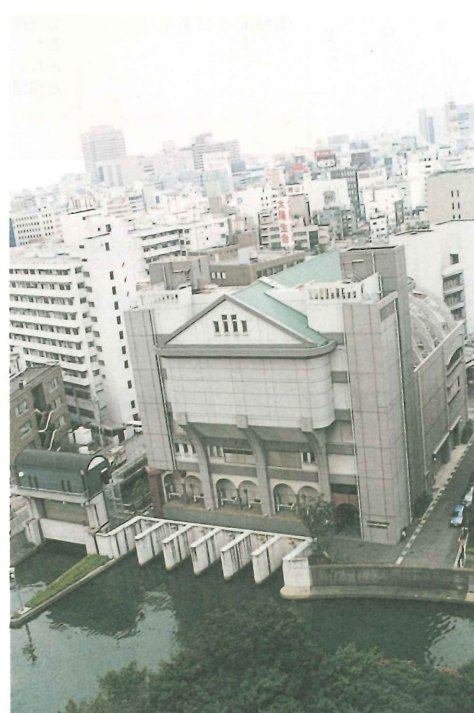
写二 葭川排水機場
