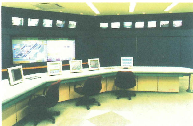
排水機場操作室
