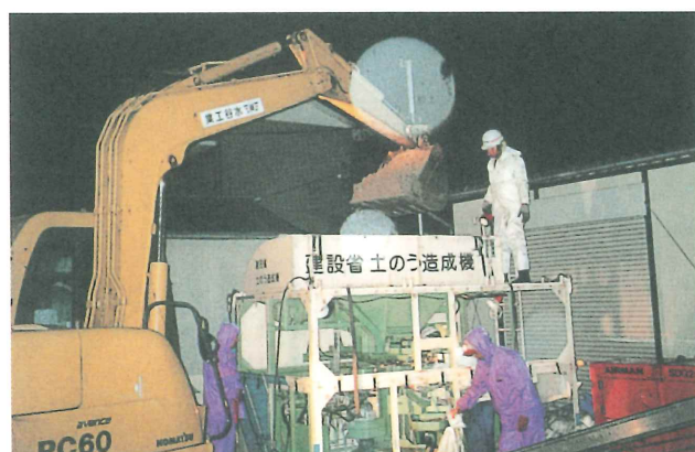
土のう造成機稼動状況
