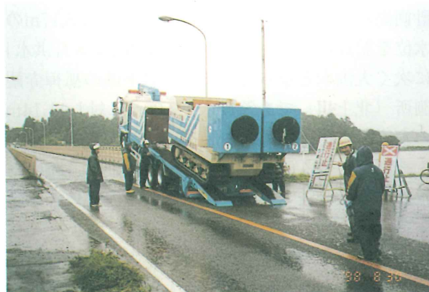
ポンプ車搬入状況
