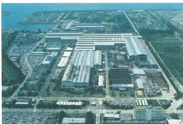
高砂製作所 全景
