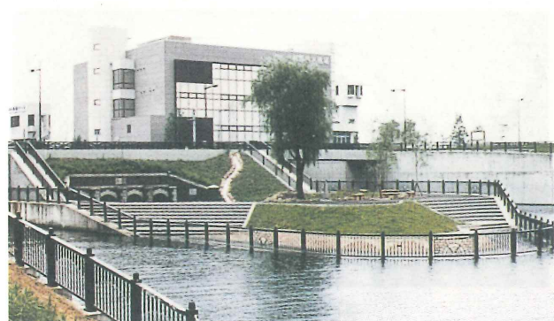
柳原排水機場
