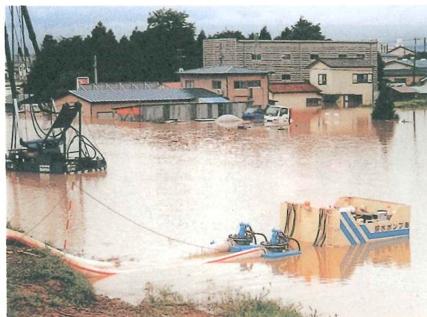
ポンプ車稼動状況
