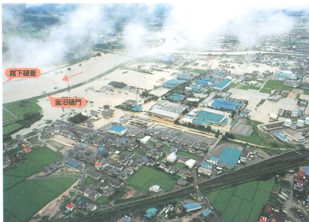
被害状況（郡山市）
