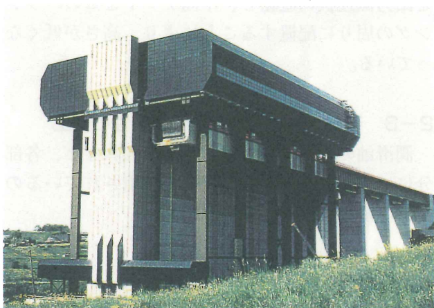
写-2 ストレピー・ティーユリフトの全景
