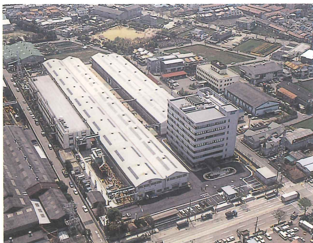
日立機電工業(株)本社、尼崎事業所
