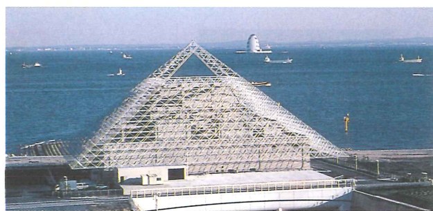
写一1 浮島換気所
