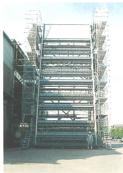
除塵機工場仮組
