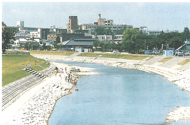
完成した水辺のコミュニティーゾーン
