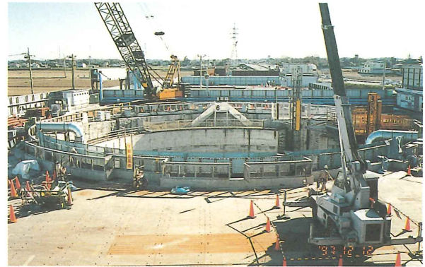
第3工区の状況
