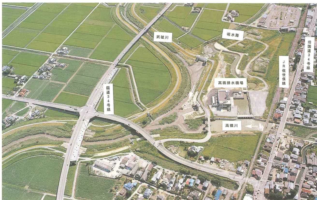
写一1 高橋排水機場全景
