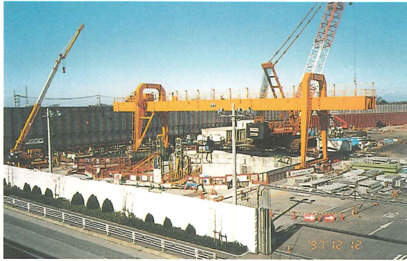
第2工区の状況
