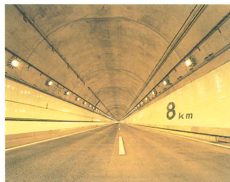
写-5 東京湾アクアトンネル
