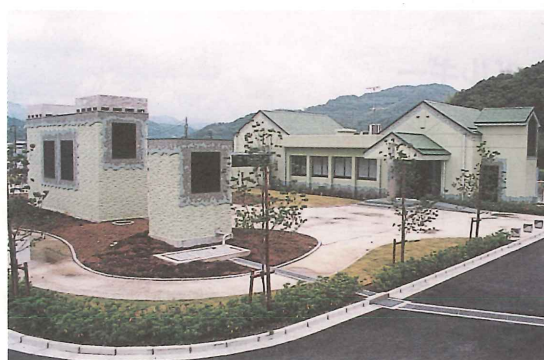
写一1 ポンプ室上部公園施設
