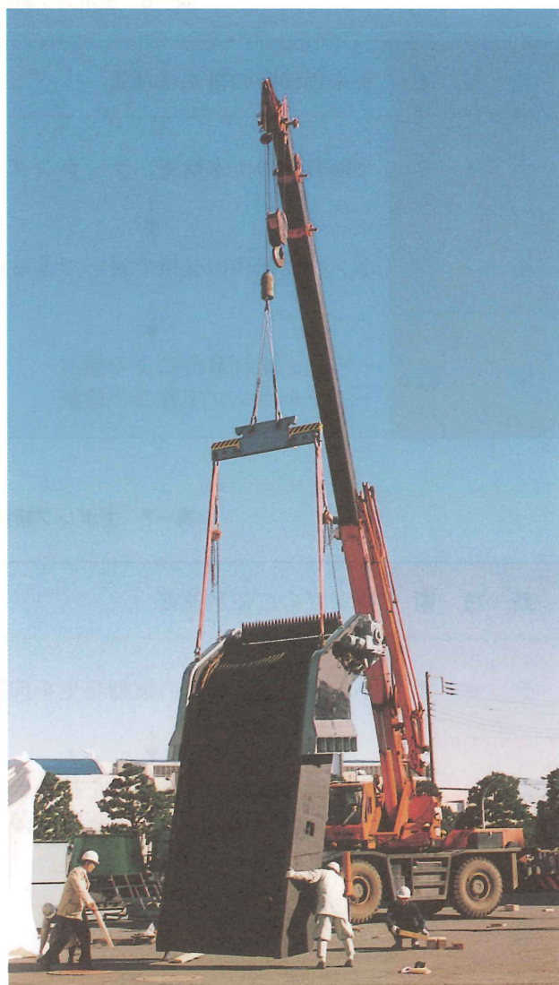
写-1 開発機を吊った状況
