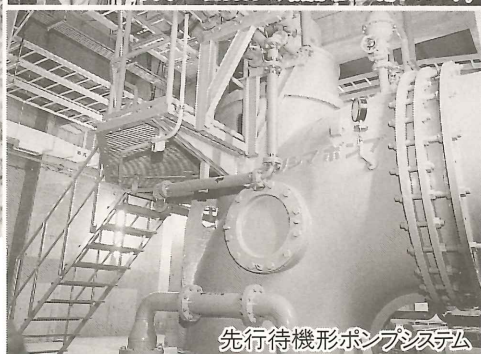
大容量排水ポンプ設備 (写真: 口径3600mm軸流ポンプ用フローベラ)
