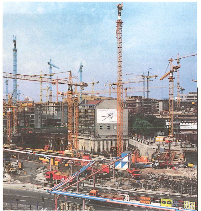
写-4 ベルリン市内の建設ラッシュ 排水用パイプラインが走っている
