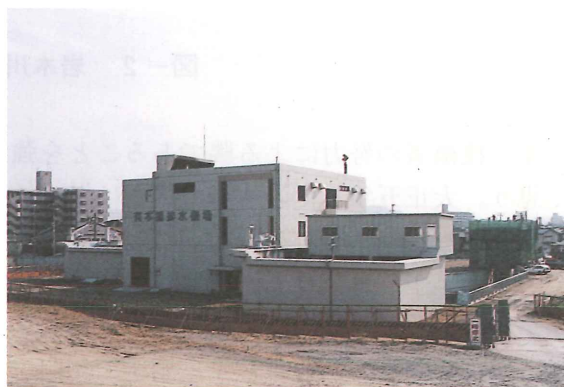
写－1 有本揚排水機場全景
