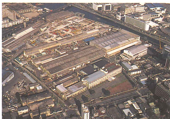
写－1 羽田工場全景
