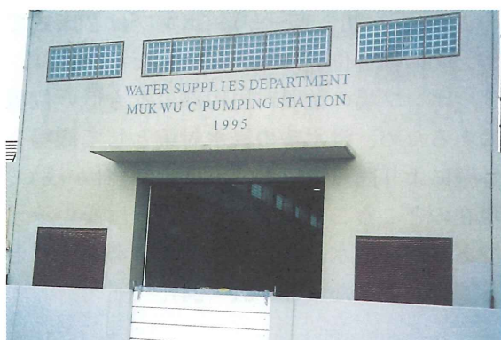
写-23 ムック・ウ・Cポンプ場の浸水対策 機場への浸水を防止するため周囲を外 壁と角落しにより囲っている。
