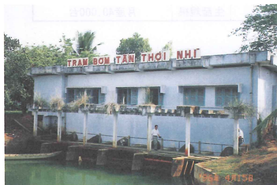
写-18 トン・ホイ・ニー村ポンプ場の外観 用途：揚水 建設：1977年 運転費用の面よりあまり稼働させていない
