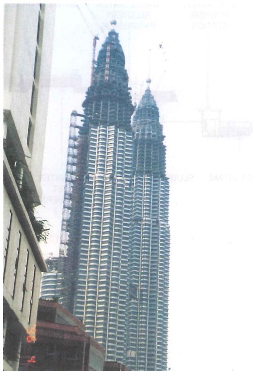
写－３ 建設中のクアラルンプールの二連の高層ビル
