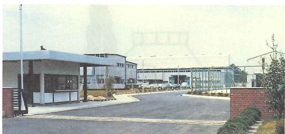
写－2 米子南工場
