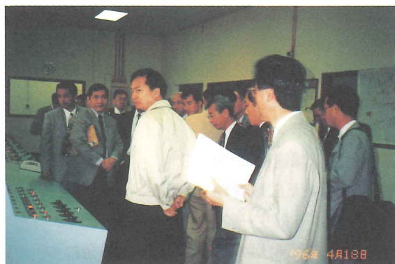
写-22 ムック・ウ・Cポンプ場の操作制御室を調査中の団員
