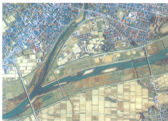
写－2 河川改修後の雄物川
