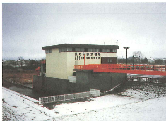
写-1 泉の沼排水機場全景
