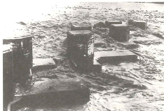
写-3 常願寺川における中出水中の ピストル水制の状況
