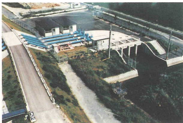
写－2 仲沖救急排水機場
