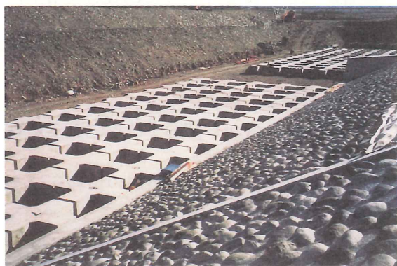
写-2 施工中の十字ブロック (常願寺川11.5km付近)
