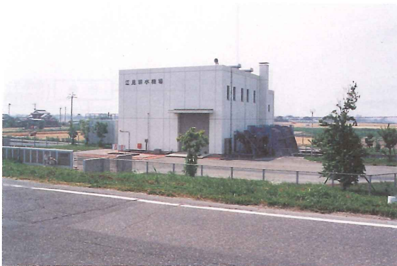
写-3 江見排水機場全景
