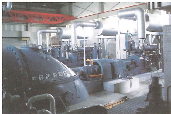
写-2 江見（下流）排水機場ポンプ室
