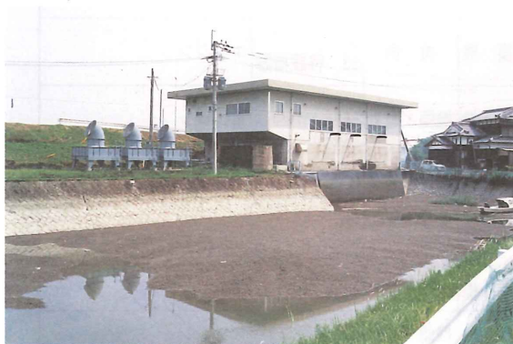
写-1 江見（下流）排水機場全景
